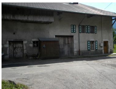
Vue des parties agricoles en façade principale. Phot. Jérôme Daviet IVR82_20117400756NUCA
