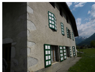
Vue du mur pignon ouest avec les baies du logis. Phot. Jérôme Daviet IVR82_20117400757NUCA
