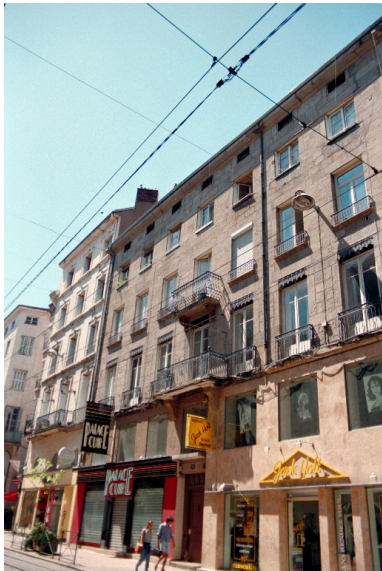
Façade principale Phot. Cendrine Sanquer IVR82_19974201869ZE
