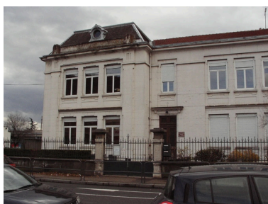
avant-corps ouest Phot. Benoît Chapelle IVR82_20073800145NUCA
