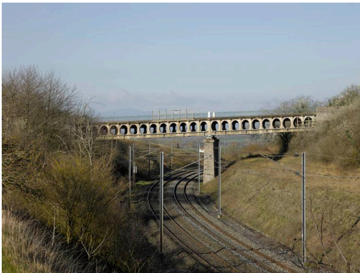
Le pont de Randan enjambant la ligne Vichy - Riom.
