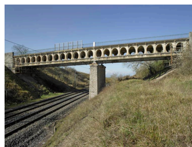
Le pont de Randan depuis les abords de la voie ferrée. Phot. Jean-Michel Périn IVR84_20166300084NUC4A
