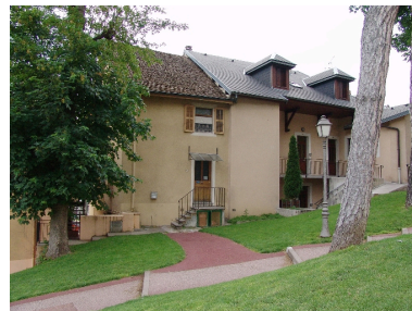
Façade postérieure Phot. François Fouger IVR82_20057300530NUCA
