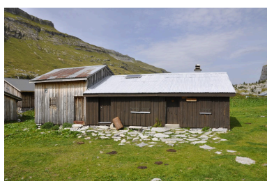
Vue d'ensemble des deux chalets contigus
