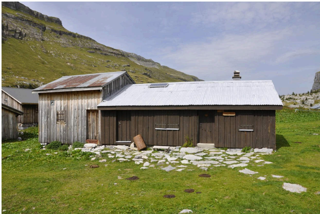
Vue d'ensemble des deux chalets contigus
