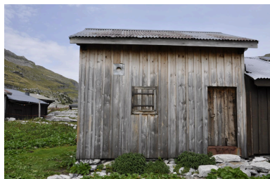
Vue de la façade antérieure sud Phot. Samir Mahfoudi IVR84_20227402319NUCA
