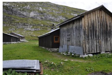
Vue de l'élévation nord-ouest Phot. Samir Mahfoudi IVR84_20227402321NUCA
