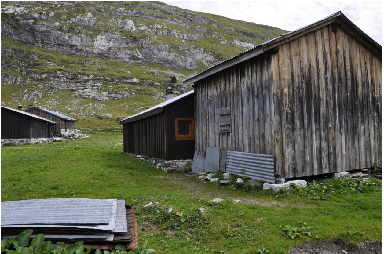
Vue de l'élévation nord-ouest
