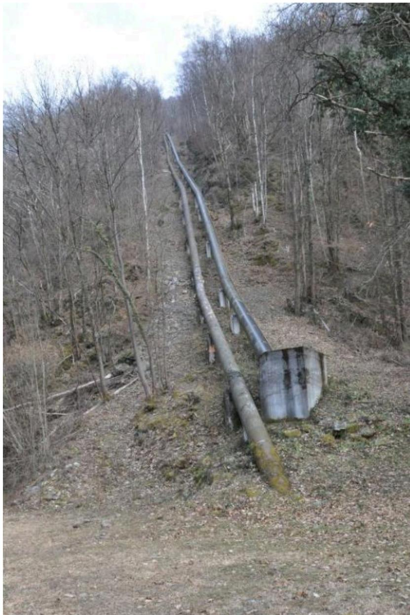
A droite, la conduite forcée de la centrale d'Argentine 1. A gauche, l'ancienne conduite aujourd'hui inutilisée.
