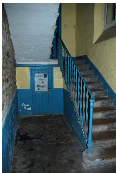
Vue intérieure : départ de l'escalier, premier repos desservant le bâtiment sur cour Phot. Magali Delavenne IVR84_20166902281NUCA
