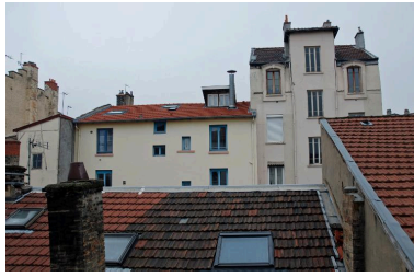
A l'extrême gauche, vue de la tour d'escalier hors-oeuvre, dernier étage en surélévation en pan-de-bois Phot. Magali Delavenne IVR84_20166902276NUCA
