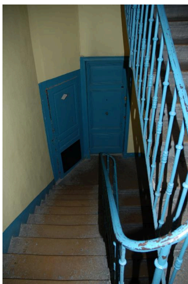
Vue intérieure : l'escalier Phot. Magali Delavenne IVR84_20166902284NUCA
