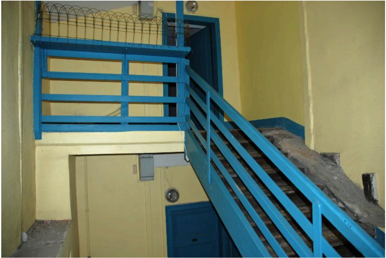
Vue intérieure : le palier du dernier niveau, en surélévation par rapport à l'ancien faîte de toit
