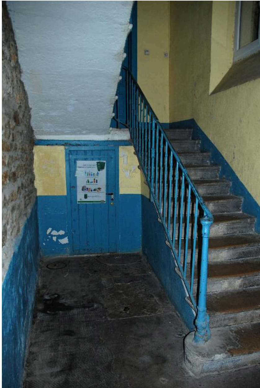
Vue intérieure : départ de l'escalier, premier repos desservant le bâtiment sur cour
