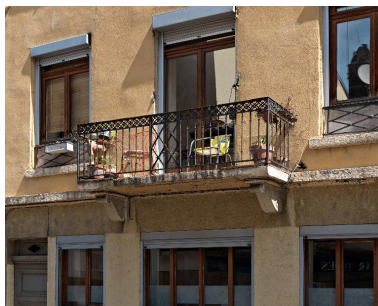
Détail de l'élévation sur rue, balcon du premier étage Phot. Eric Dessert IVR84_20176900519NUCA
