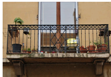
Détail de l'élévation sur rue : garde-corps en fer forgé Phot. Magali Delavenne IVR84_20166902280NUCA
