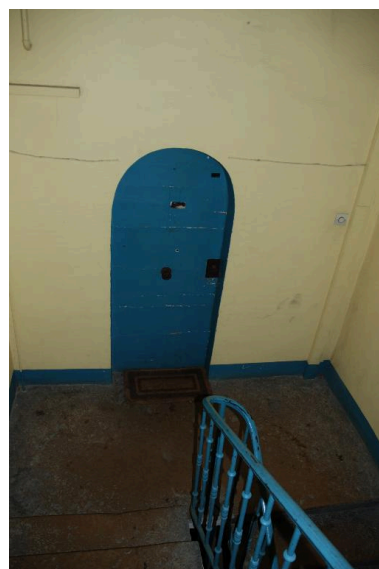
Vue intérieure : petite porte sur le troisième repos Phot. Magali Delavenne IVR84_20166902283NUCA
