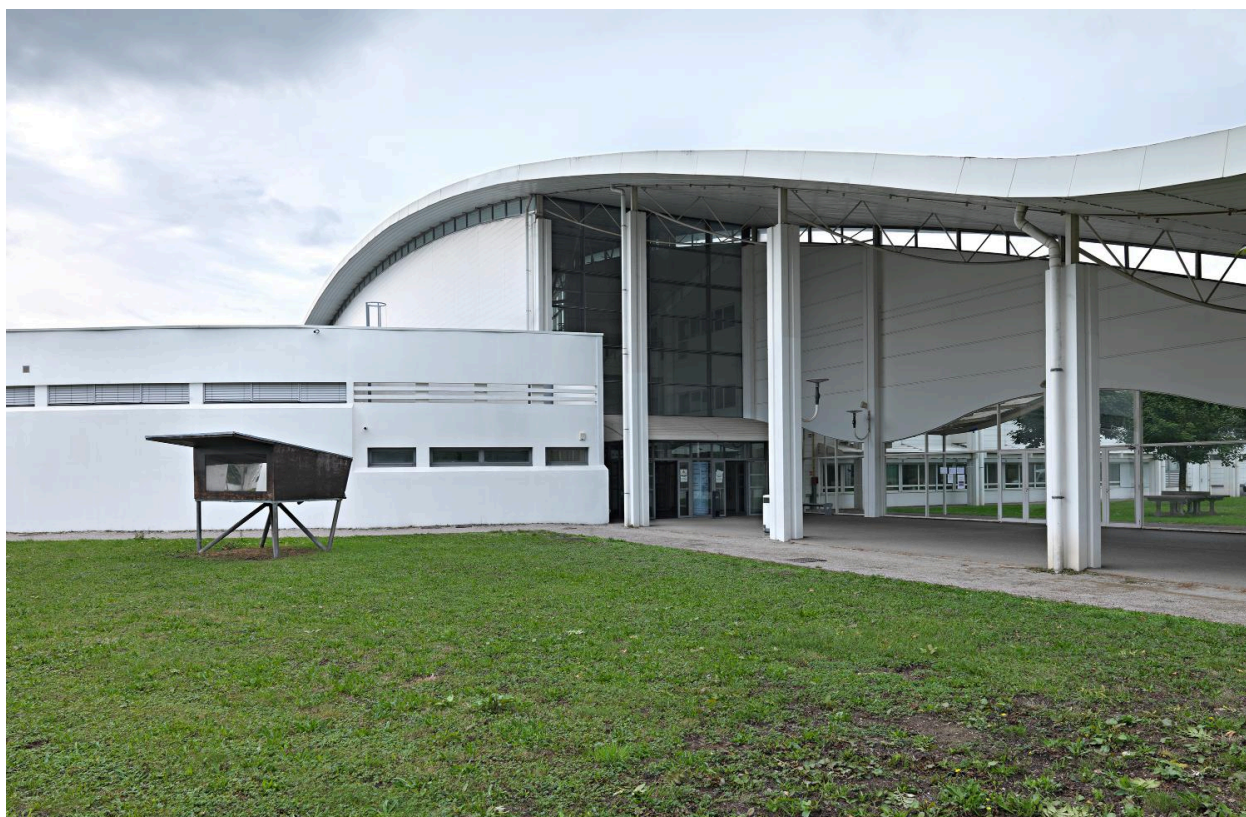
Vue d'ensemble de l'installation devant les bâtiments du lycée.
