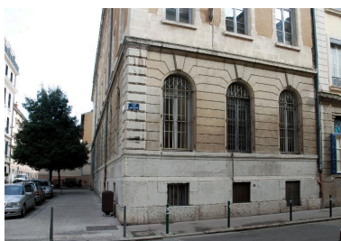
Élévation latérale : détail du rez-de-chaussée Phot. Catherine Guégan IVR84_20176902015NUCA
