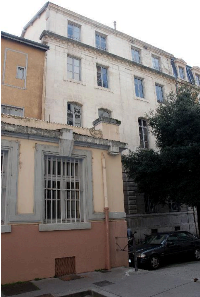
Elévation principale, vue partielle depuis le nord-ouest
