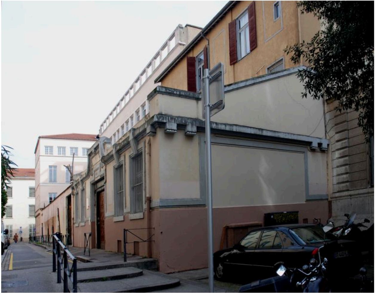
Vue d'ensemble du 2e corps de bâtiment impasse Catelin, depuis le sud
