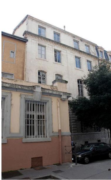
Elévation principale, vue partielle depuis le nord-ouest Phot. Catherine Guégan IVR84_20176902021NUCA
