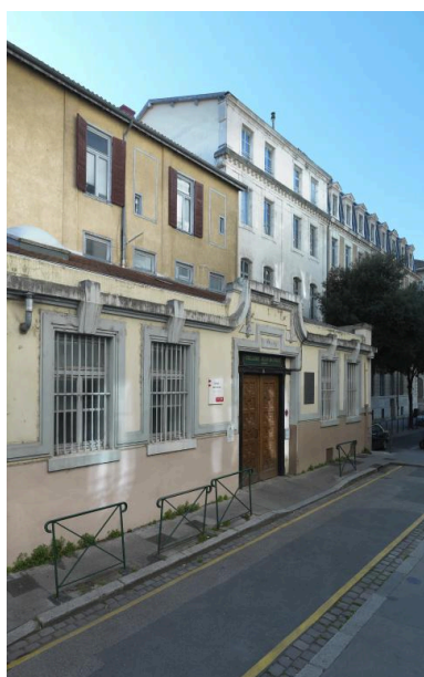
Elévations depuis le nord-ouest Phot. Franck Trabouillet, Phot. Jérémy Cuenin IVR84_20196900265NUCAQ
