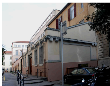
Vue d'ensemble du 2e corps de bâtiment impasse Catelin, depuis le sud Phot. Catherine Guégan IVR84_20176902017NUCA
