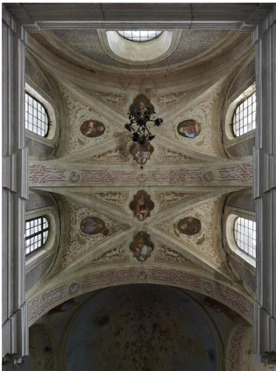
Vue des voûtes de la nef.
