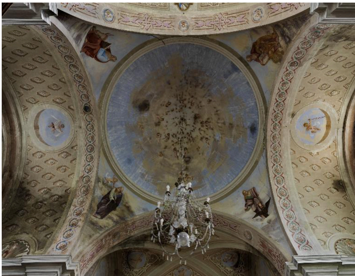
Vue d'ensemble du couvrement de la croisée.
