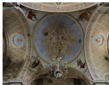
Vue d'ensemble du couvrement de la croisée.
