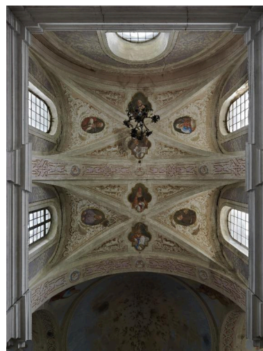
Vue des voûtes de la nef.
