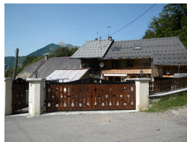
Vue de la façade principale d'une ferme remaniée (2008 F6 814) Phot. Jérôme Daviet IVR82_20137401135NUCA
