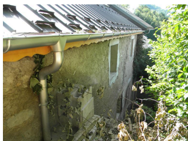
Façade arrière d'une ferme remaniée (2008 F6 814) Phot. Jérôme Daviet IVR82_20137401136NUCA
