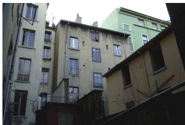
Elévation postérieure et vue du bâtiment en fond de cour Phot. Maryannick Chalabi IVR82_20016900244NUCA
