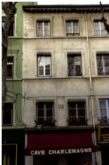
Détail des travées de façade Phot. Maryannick Chalabi IVR82_20016900237NUCA
