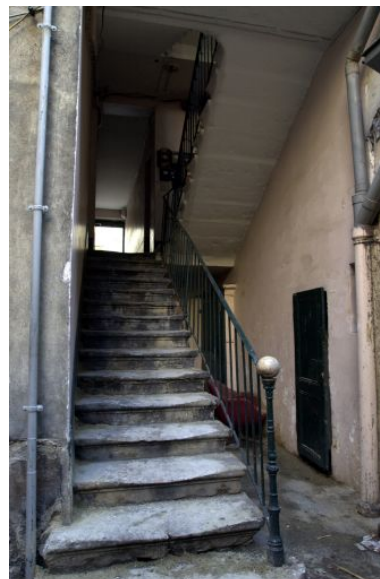
Vue de la descente d'escalier vers la cour. Phot. Maryannick Chalabi IVR82_20016900245NUCA
