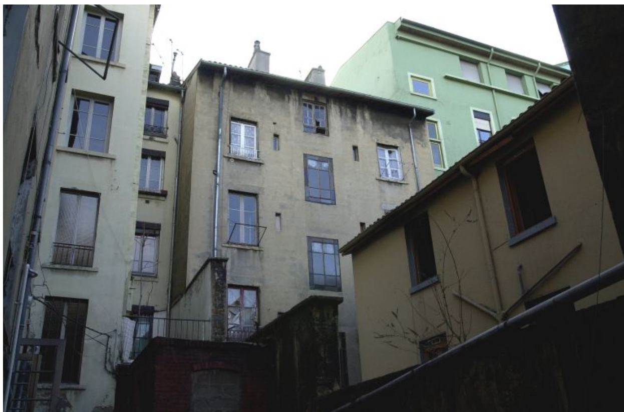
Elévation postérieure et vue du bâtiment en fond de cour
