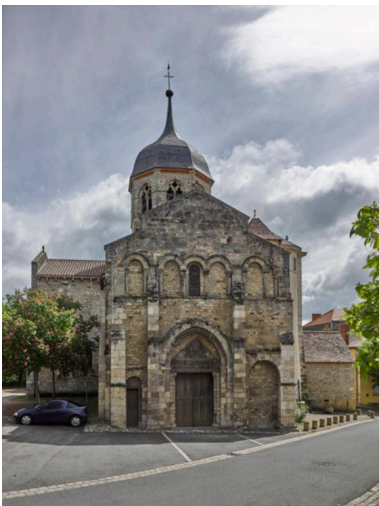
Vue générale de la façade occidentale
