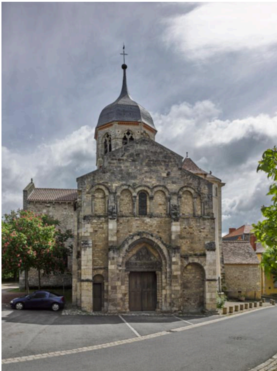
Vue générale de la façade occidentale
