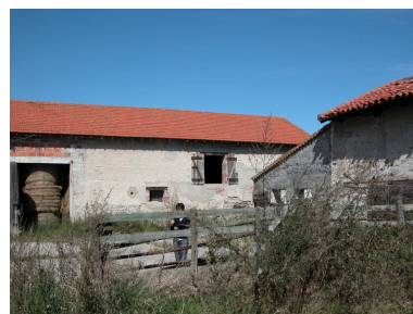
Vue de la grange- étable nord, partie est. Phot. Thierry Monnet
