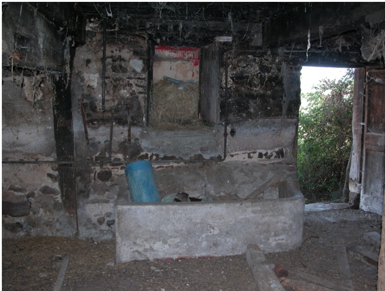
Vue intérieure du logis : laiterie (?).
