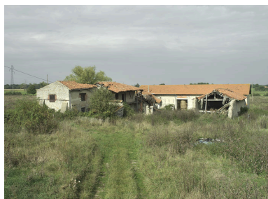
Vue générale. Phot. Didier Gourbin IVR82_20074201256NUCA
