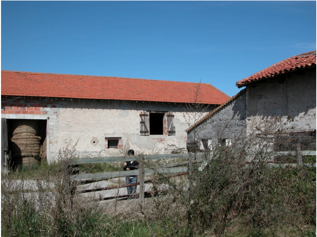
Vue de la grange-étable nord, partie est.
