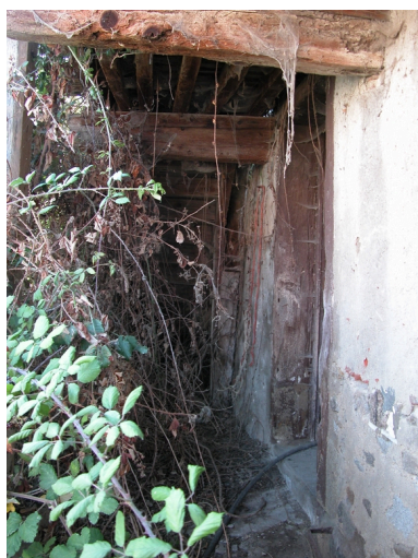
Vue de l'espace sous l'escalier de l'aître. Phot. Thierry Monnet IVR82_20134202849NUCA
