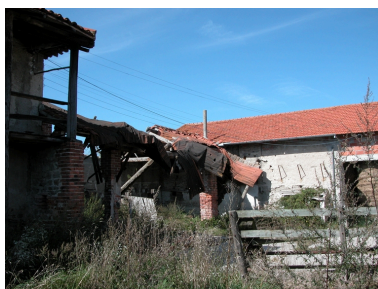
Vue de la grange- étable nord, partie ouest. Phot. Thierry Monnet
