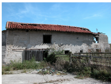
Vue des étables est. Phot. Thierry Monnet IVR82_20134202844NUCA
