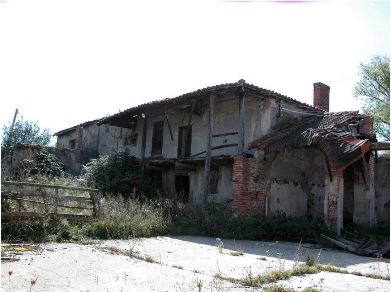
Vue d'ensemble du logis depuis le nord-est.
