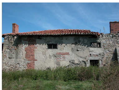
Vue arrière du logis, depuis l'ouest. Phot. Thierry Monnet IVR82_20134202857NUCA
