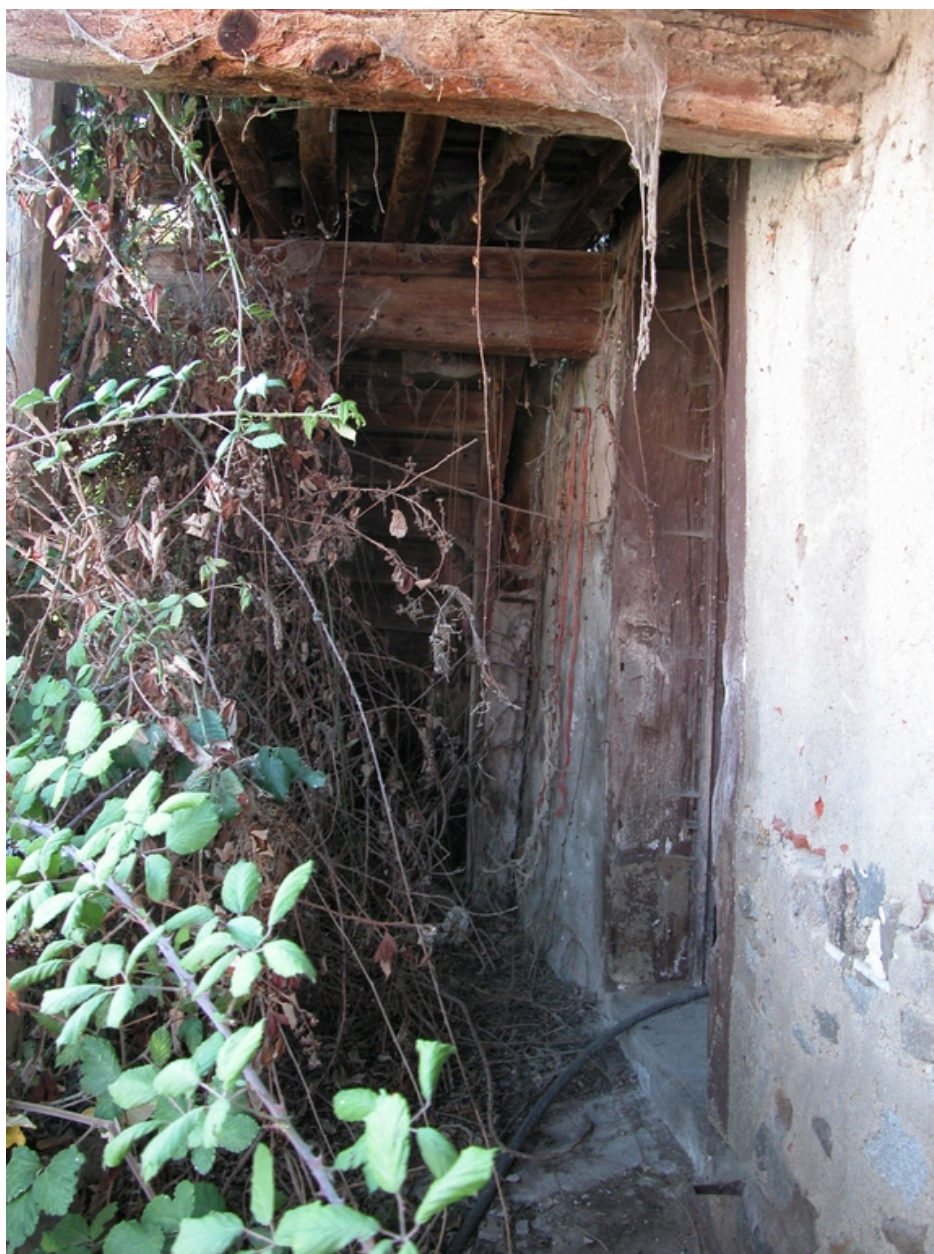
Vue de l'espace sous l'escalier de l'aître.
