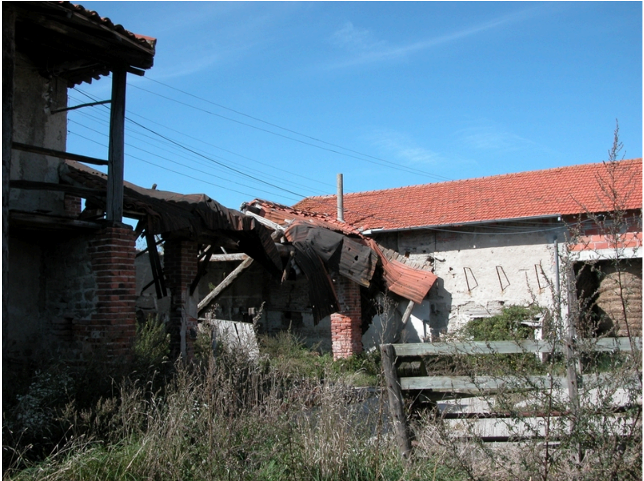
Vue de la grange-étable nord, partie ouest.
