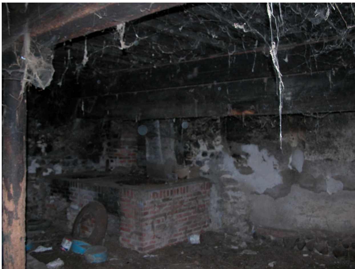
Vue intérieure du logis : ancien four à pain, puis chaudière.
