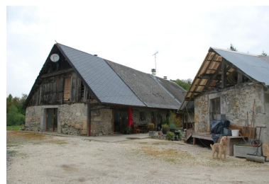
Vie d'ensemble depuis le sud-ouest : extrémité du bâtiment principal et four à pain. Phot. Thierry Monnet IVR84_20207400406NUCA
