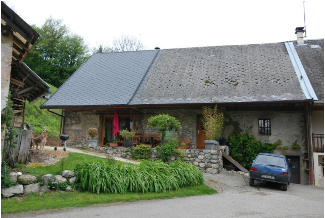
Vue d'ensemble, partie sud-ouest.
