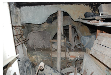
Vue intérieure du four à pain. Phot. Thierry Monnet IVR84_20207400404NUCA
