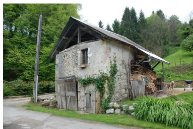
Vue du four à pain, côté aval : entrée du four et de la porcherie-poulailler. Phot. Thierry Monnet IVR84_20207400403NUCA
