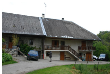
Vue d'ensemble, partie nord-est. Phot. Thierry Monnet IVR84_20207400401NUCA
