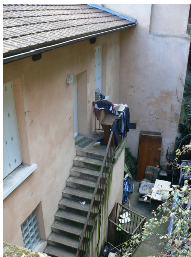
Façade arrière Phot. Isabelle Dupuis IVR82_20093800431NUCA
