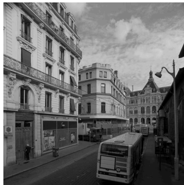
Vue depuis le sud, à la hauteur du couvent des cordeliers Saint-Bonaventure Phot. Eric Dessert IVR82_20046901137NUC
