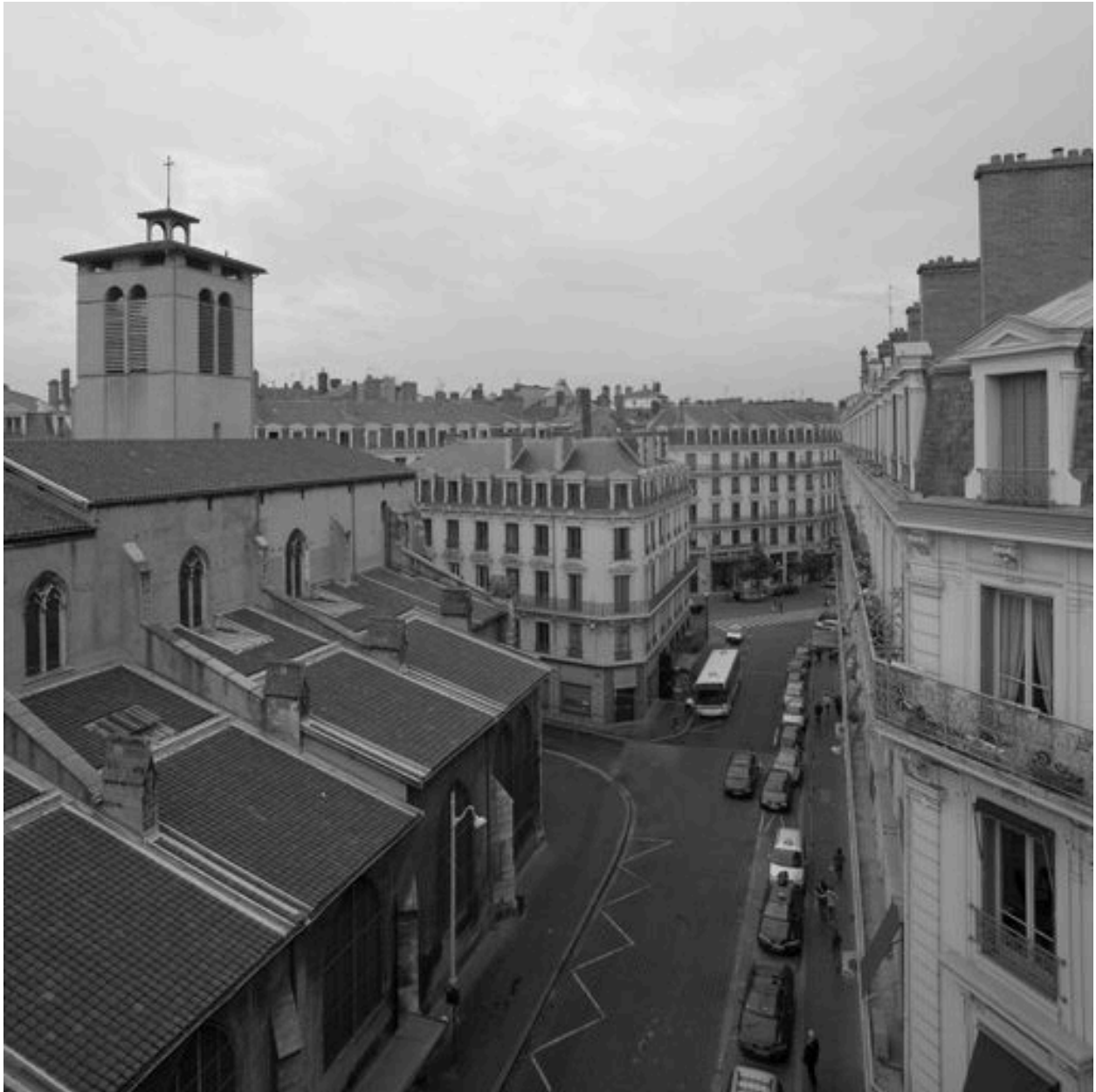
Vue générale depuis le toit du Grand Bazar au nord
