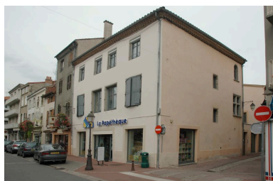
Vue générale, angle rue Tupinerie rue Précomtal. Phot. Simone Hartmann-Nussbaum IVR82_20114201213NUCA
