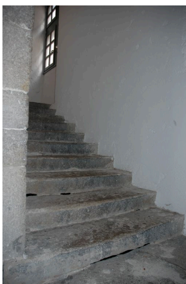
Escalier à mur noyau plein. Phot. Simone Hartmann-Nussbaum IVR82_20114201217NUCA
