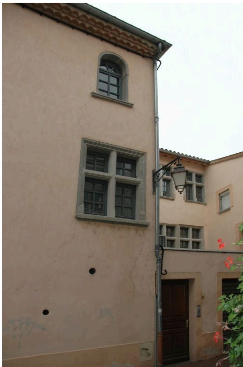
Vue partielle depuis la rue Précomtal en direction de la cour
