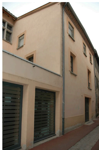
Élévation latérale, ancienne dépendance (?). Phot. Simone Hartmann-Nussbaum IVR82_20114201215NUCA
