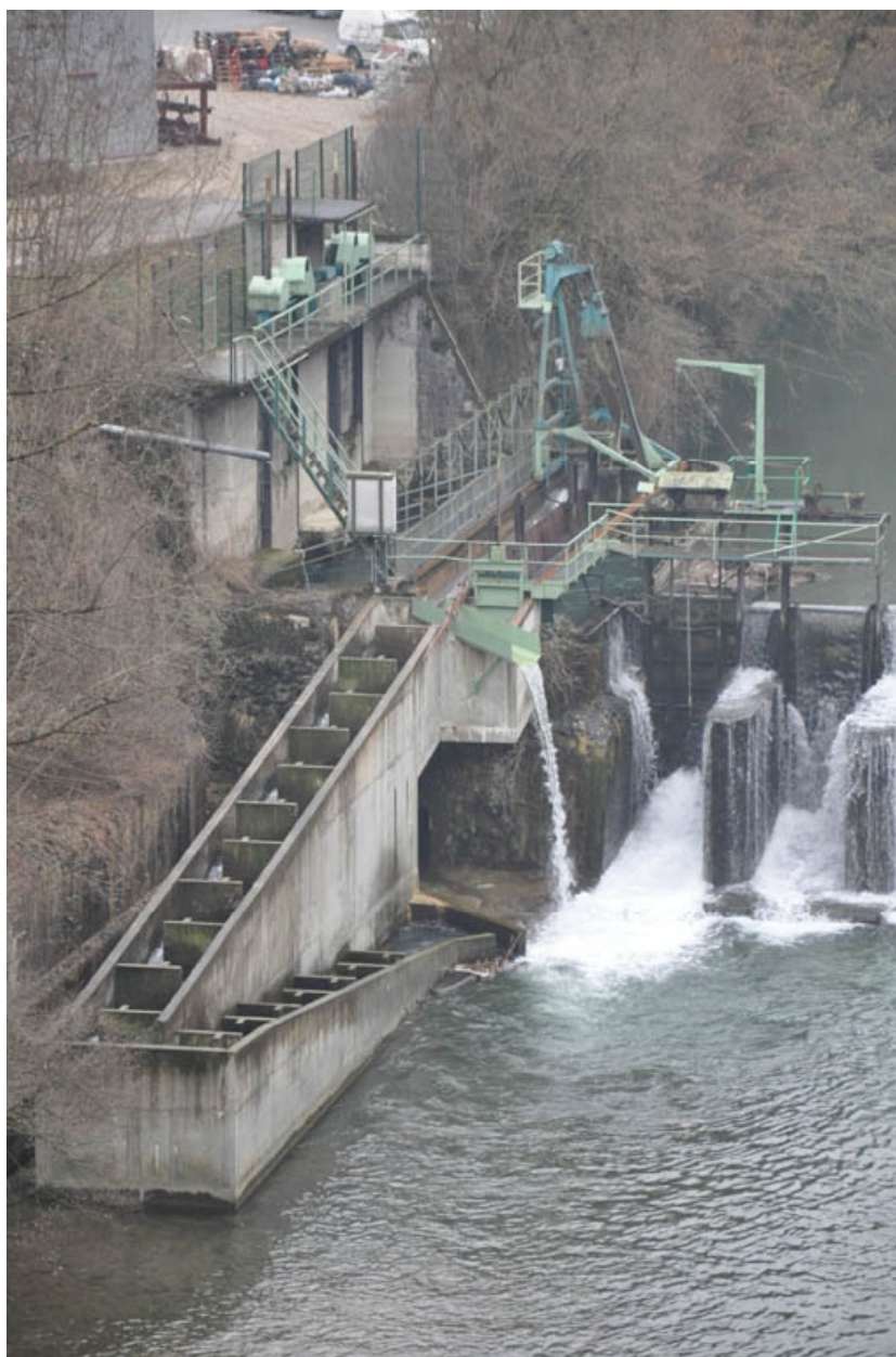
Vue de la centrale hydroélectrique avec le système de vannage et l'échelle à poissons
