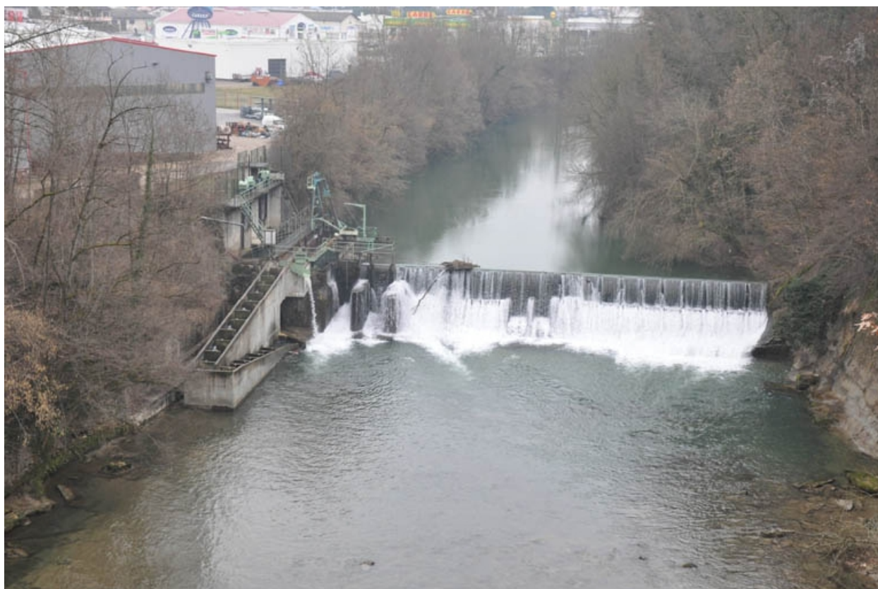
Vue générale de la centrale hydroélectrique
