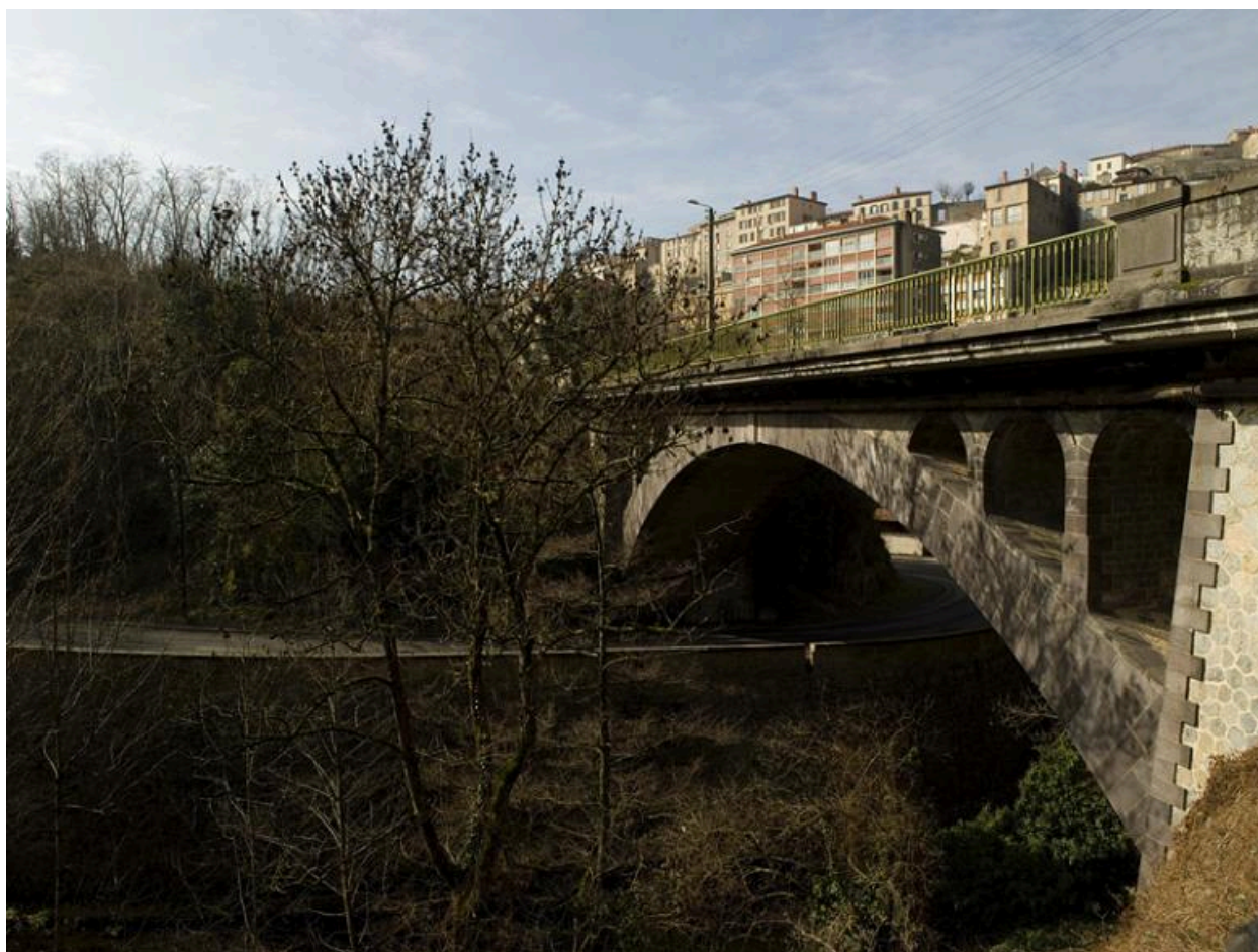
Le pont de Saint-Roch depuis la rive droite.
