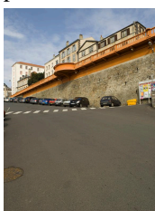
Mur de soutènement du "Rempart".
