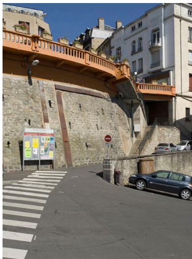
Détail du mur de soutènement du "Rempart". Phot. Jean-Michel Périn IVR83_20116300627NUC4A
