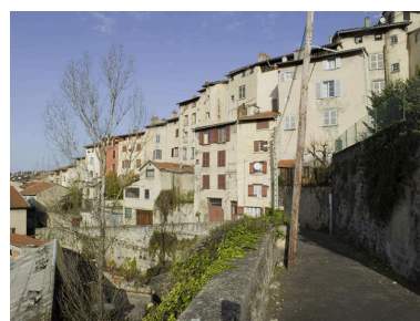
La rue Anna-Chabrol, sur l'emplacement de l'une des enceintes médiévales. Phot. Jean-Michel Périn IVR83_20096300379NUC4A
