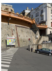
Détail du mur de soutènement du "Rempart".
