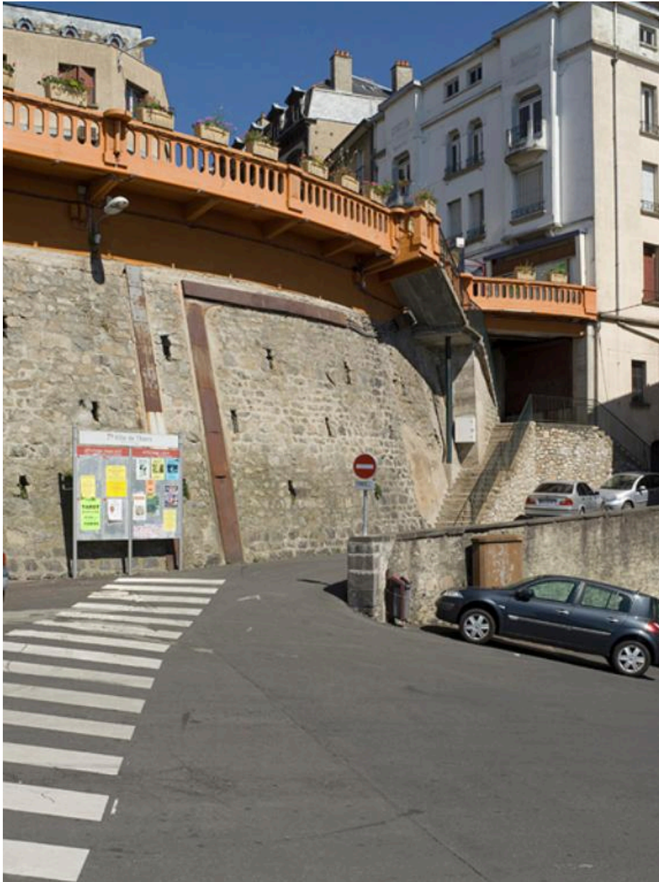
Détail du mur de soutènement du "Rempart".
