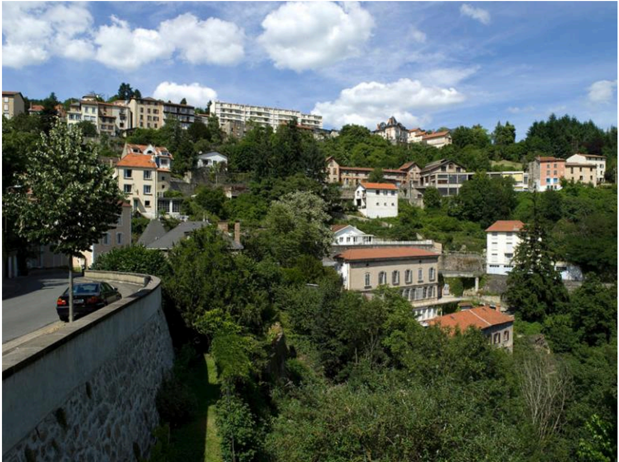
Portion de l'avenue Pierre-Guérin maintenue par un haut mur de soutènement.
