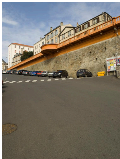
Mur de soutènement du "Rempart". Phot. Jean-Michel Périn IVR83_20116300188NUC4A
