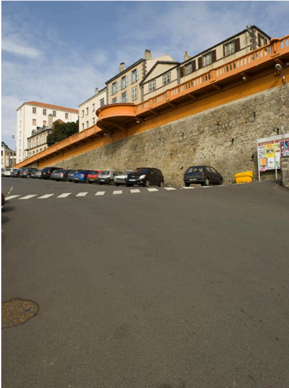
Mur de soutènement du "Rempart".
