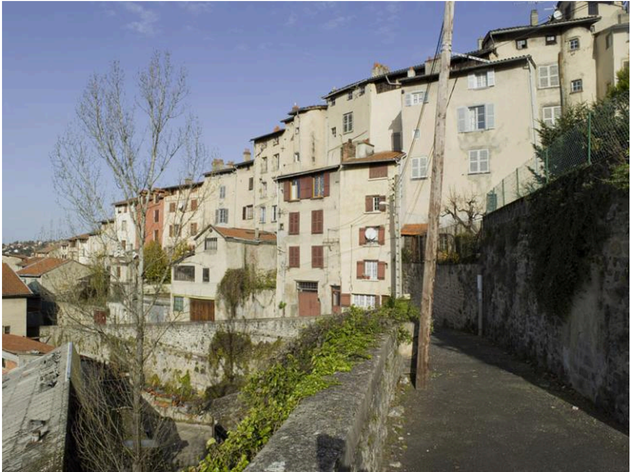
La rue Anna-Chabrol, sur l'emplacement de l'une des enceintes médiévales.
