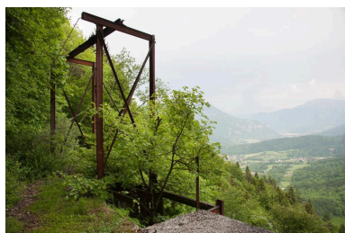
Vue du chevalement du téléphérique sur la plateforme du travers-banc.
