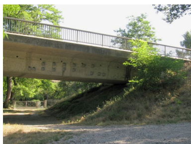
Culée gauche, face aval, vue générale (depuis la rive gauche) Phot. I. Havard IVR82_20100700335NUCA
