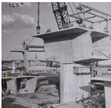
[La construction du nouveau pont de Bourg-Saint-Andéol]. [12/1970]. 1 fotogr. pos. : n. et b. (AD Ardèche. 25 Fi 96, n°163) Phot. F. Bardoneschi, Autr. auteur inconnu 1_ IVR82_20100700079NUCAB
