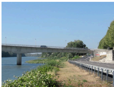
Vue partielle, culée et travée droite, face amont (depuis la rive droite) Phot. I. Havard IVR82_20100700333NUCA
