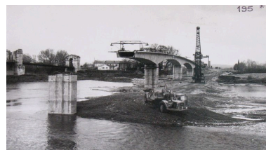
[La construction du nouveau pont de Bourg-Saint-Andéol]. [03/1971]. 1 fotogr. pos. : n. et b. (AD Ardèche. 25 Fi 97, n°195) Phot. F. Bardoneschi, Autr. auteur inconnu 1_ IVR82_20100700081NUCAB
