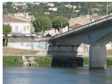
Culée et travée droite, face aval, vue générale (depuis la rive gauche) Phot. I. Havard IVR82_20100700334NUCA
