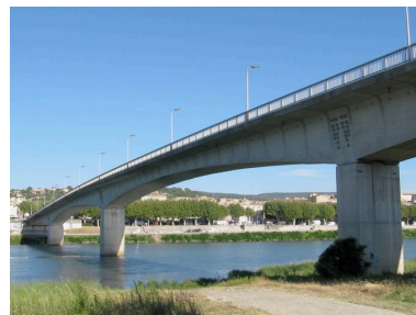
Vue partielle, de côté, face aval (depuis la rive gauche) Phot. I. Havard IVR82_20100700331NUCA
