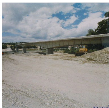
[La construction du nouveau pont de Bourg-Saint-Andéol]. [06/1971]. 1 fotogr. pos. : coul. (AD Ardèche. 25 Fi 97, n°32-064) Phot. F. Bardoneschi, Autr. auteur inconnu 1_ IVR82_20100700080NUCAB
