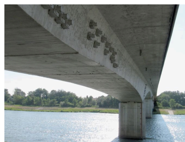
Vue partielle, de dessous, tablier et piles (depuis la rive droite) Phot. I. Havard IVR82_20100700337NUCA
