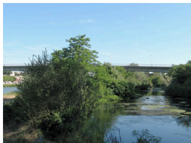
Vue partielle, travée gauche, face aval (depuis la rive gauche) Phot. I. Havard IVR82_20100700332NUCA
