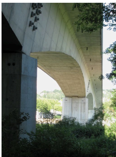
Vue partielle, de dessous, tablier et piles, face amont (depuis la rive gauche) Phot. I. Havard IVR82_20100700336NUCA
