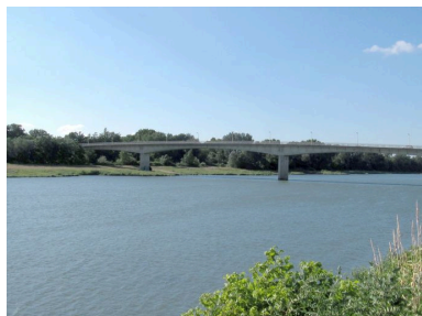
Vue partielle, face amont (depuis la rive droite) Phot. I. Havard IVR82_20100700329NUCA
