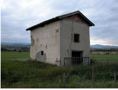
Vue générale Phot. Thierry Monnet IVR82_20134200280NUCA
