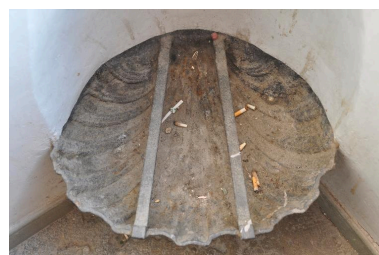
Vasque placée dans l'angle des repos de l'escalier Phot. Magali Delavenne IVR84_20166902239NUCA
