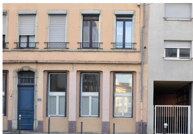
Vue du rez-de-chaussée et des piliers de l'ancienne boutique Phot. Magali Delavenne IVR84_20166902235NUCA
