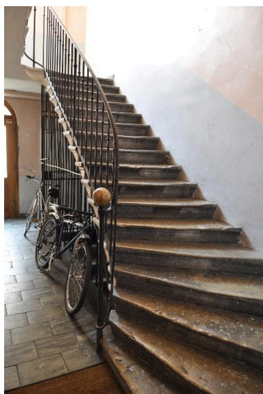
Vue intérieure : départ de l'escalier Phot. Magali Delavenne IVR84_20166902237NUCA
