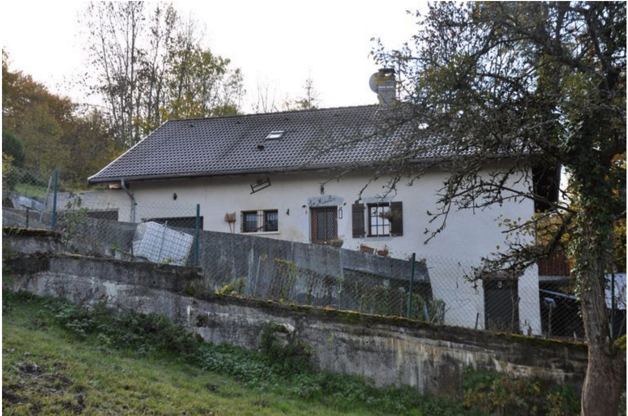
Détail de la façade antérieure ouest du bâtiment du moulin
