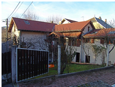
Aile en retour à l'arrière Phot. François Fouger IVR82_20087300106NUCA
