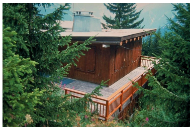
Vue depuis le sud Phot. Jean-François Lyon-Caen IVR82_19987300110ZA
