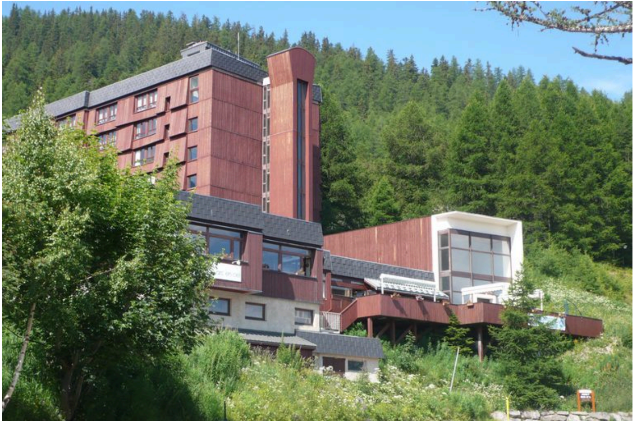
Vue générale depuis le nord-ouest. A l'arrière les Balcons de Maurienne
