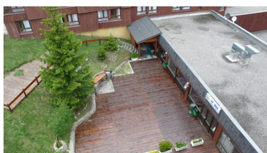
La terrasse côté sud Phot. Jean-François Lyon-Caen IVR82_20127302509NUCA
