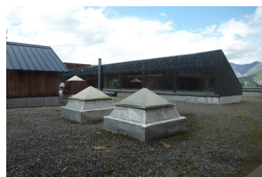
Le toit terrasse avec les prises de jour pour la salle à manger centrale Phot. Jean-François Lyon-Caen IVR82_20127302507NUCA
