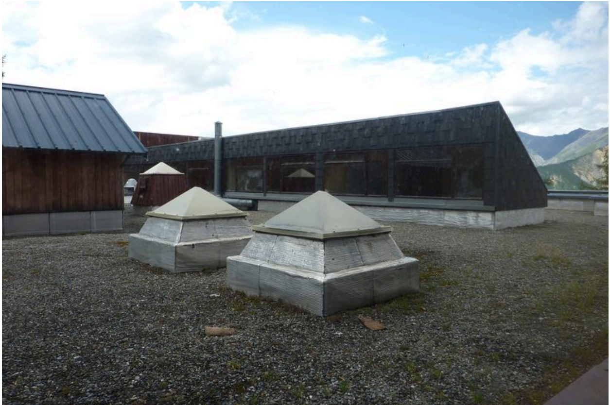
Le toit terrasse avec les prises de jour pour la salle à manger centrale
