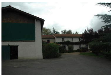
Vue partielle de la cour avec présence du logis sur cour au nord . Phot. Thierry Monnet IVR82_20144200391NUCA
