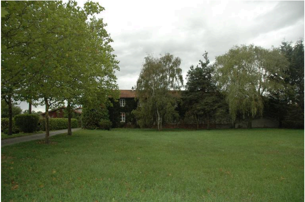
Vue d'ensemble arrière du logis.
