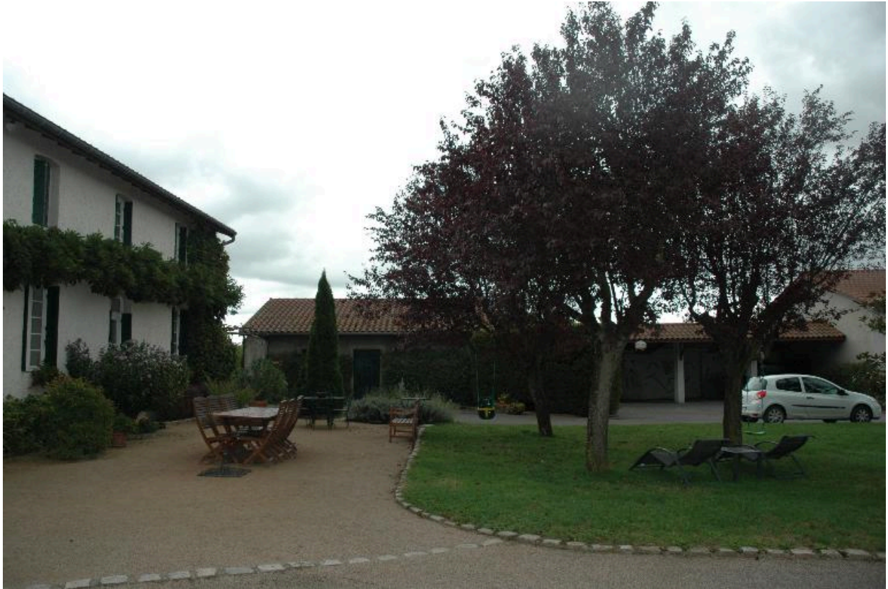
Vue d'ensemble de l'angle nord-est de la ferme.
