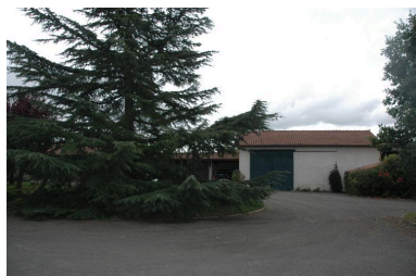
Vue d'ensemble de l'angle sud-est de la ferme. Phot. Thierry Monnet IVR82_20144200393NUCA
