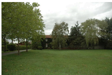
Vue d'ensemble arrière du logis. Phot. Thierry Monnet IVR82_20144200394NUCA
