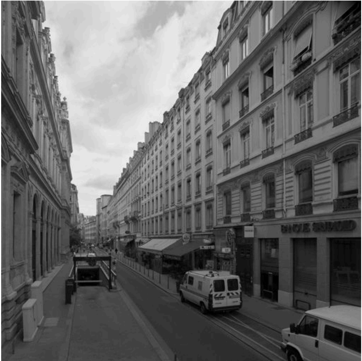
Vue d'ensemble depuis la rue de la République, vers l'ouest
