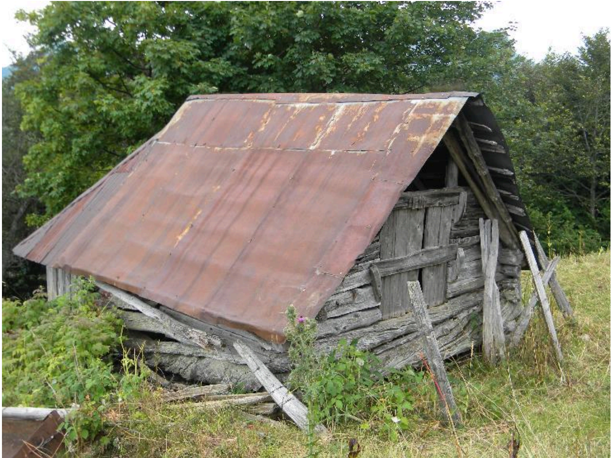
Vue de trois-quarts nord-ouest.
