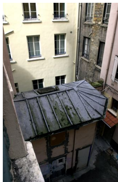
Vue de la loge de concierge depuis l'escalier Phot. Maryannick Chalabi IVR82_20016901708NUCA
