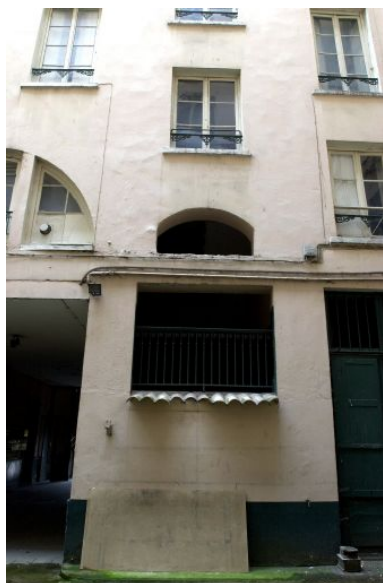
Vue de la travée d'escalier de l'immeuble sur rue Phot. Maryannick Chalabi IVR82_20016901705NUCA
