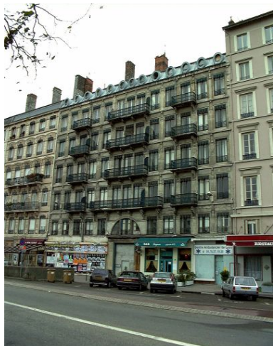
Elévation principale, cours de Verdun-Perrache Phot. Bernard Ducouret IVR82_20006900604NUCA
