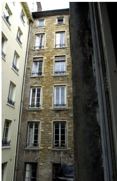
Elévation postérieure de la partie ouest de l'immeuble sur rue, au-dessus de la cour du 3 rue Delandine Phot. Maryannick Chalabi IVR82_20016901710NUCA
