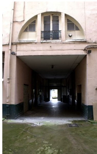
Vue du passage cocher depuis la cour Phot. Maryannick Chalabi IVR82_20016901704NUCA
