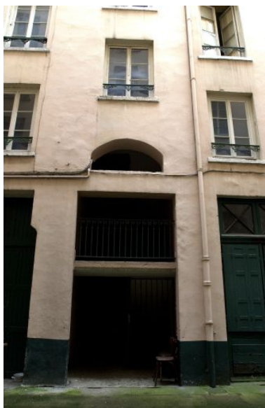
Vue de la travée d'escalier du corps de bâtiment en fond de cour Phot. Maryannick Chalabi IVR82_20016901707NUCA
