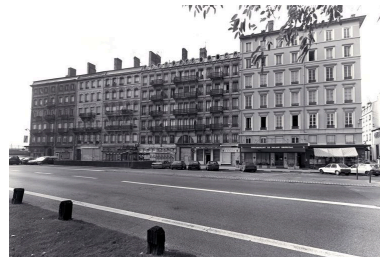
Vue d'ensemble des immeubles, 30-40 cours de Verdun-Perrache Phot. Jean-Marie Refflé IVR82_20016902480V
