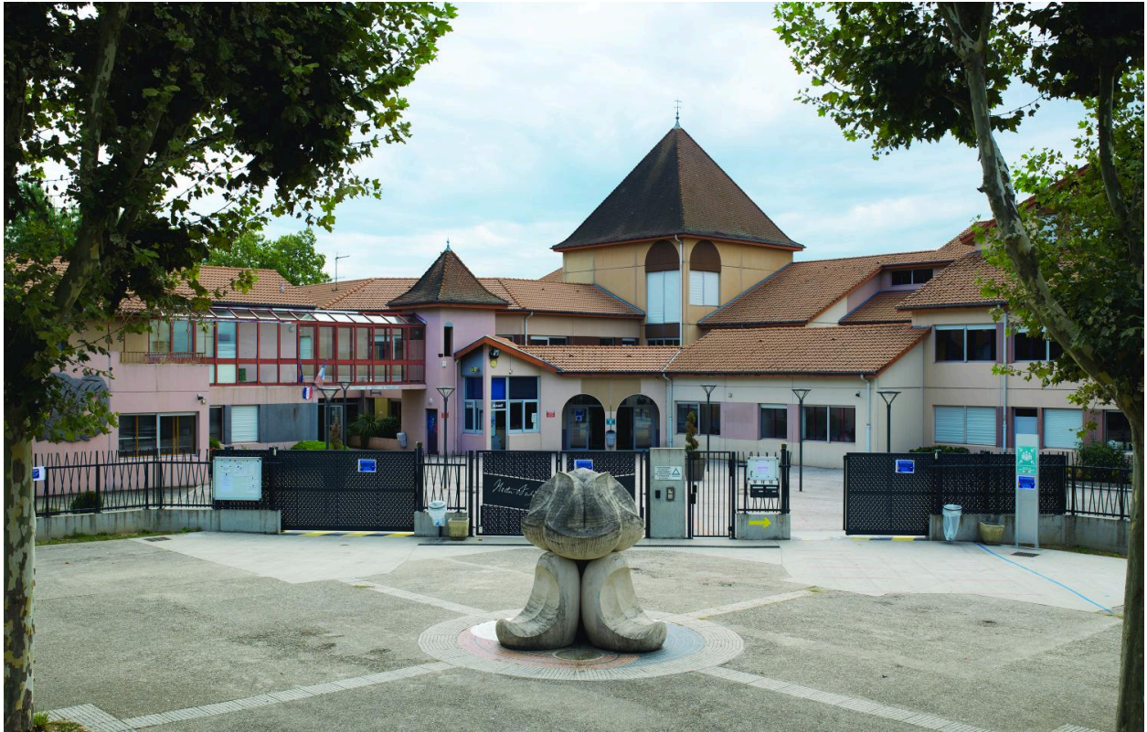
Parvis et entrée du lycée.
