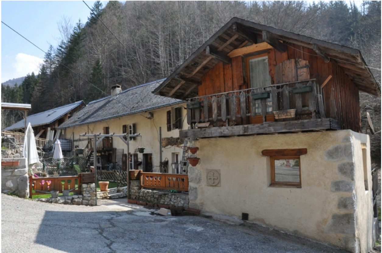
Vue du moulin, façade ouest
