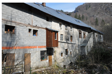
Vue générale du moulin, façade est Phot. Yannick Milleret IVR82_20107300828NUCA
