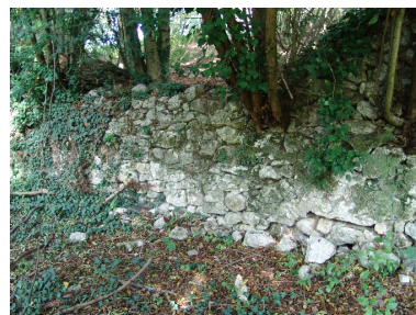
mur de soutènement Phot. François Fouger IVR82_20067300725NUCA
