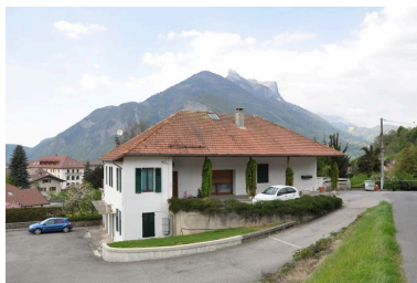
Façade antérieure est du bâtiment des bureaux de l'ancienne distillerie Phot. Samir Mahfoudi, Autr. Samir Mahfoudi IVR82_20117401075NUCA
