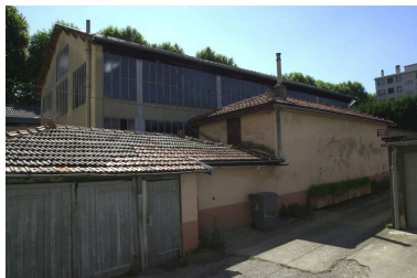
Vue de la façade arrière Phot. François Blanchetière IVR82_20016901609NUCA
