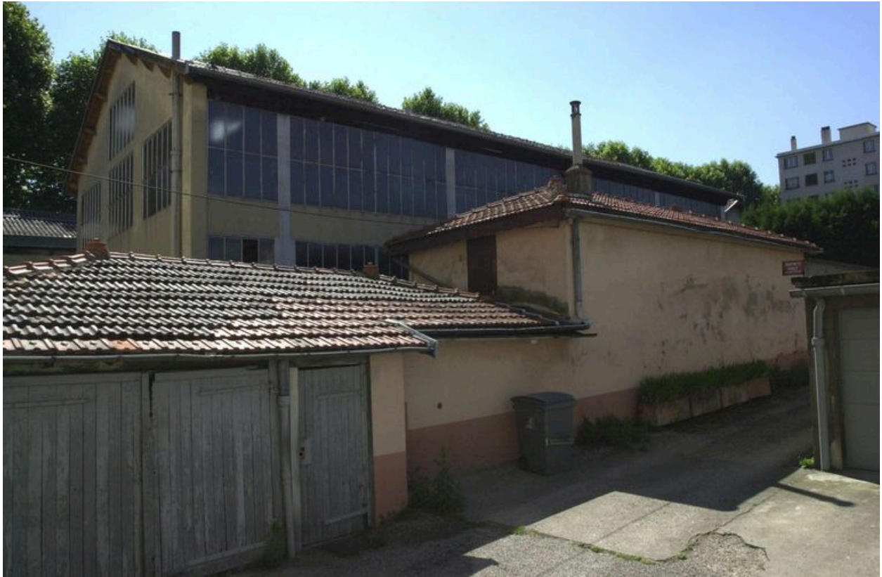
Vue de la façade arrière
