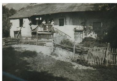
Vue ancienne du moulin (© Archives privées de la famille Brun). IVR84_20197300393NUCA
