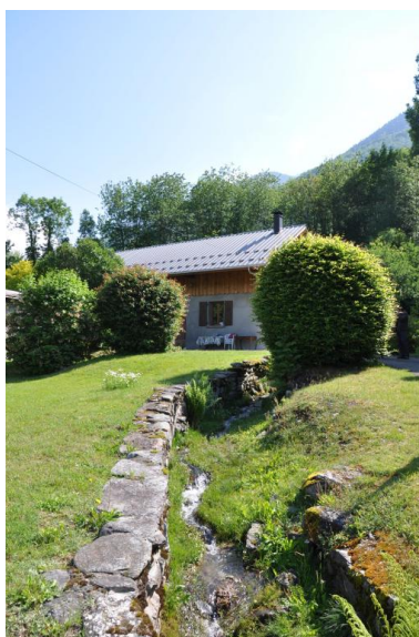
Vue aval du canal de Charrière chaude et du moulin. Phot. Clara Bérelle IVR84_20187300230NUCA
