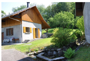
Vue du moulin et du canal de Charrière chaude. Phot. Clara Bérelle IVR84_20167308955NUCA
