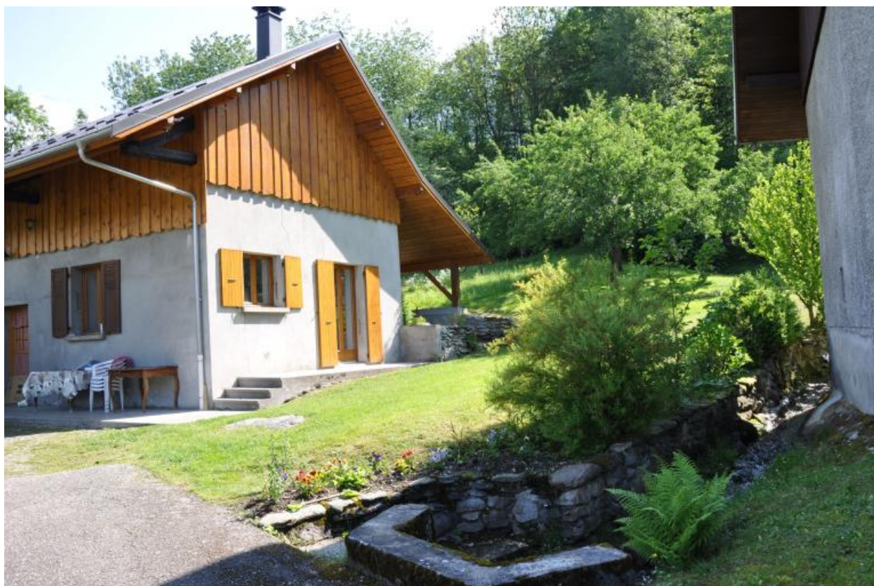
Vue du moulin et du canal de Charrière chaude.
