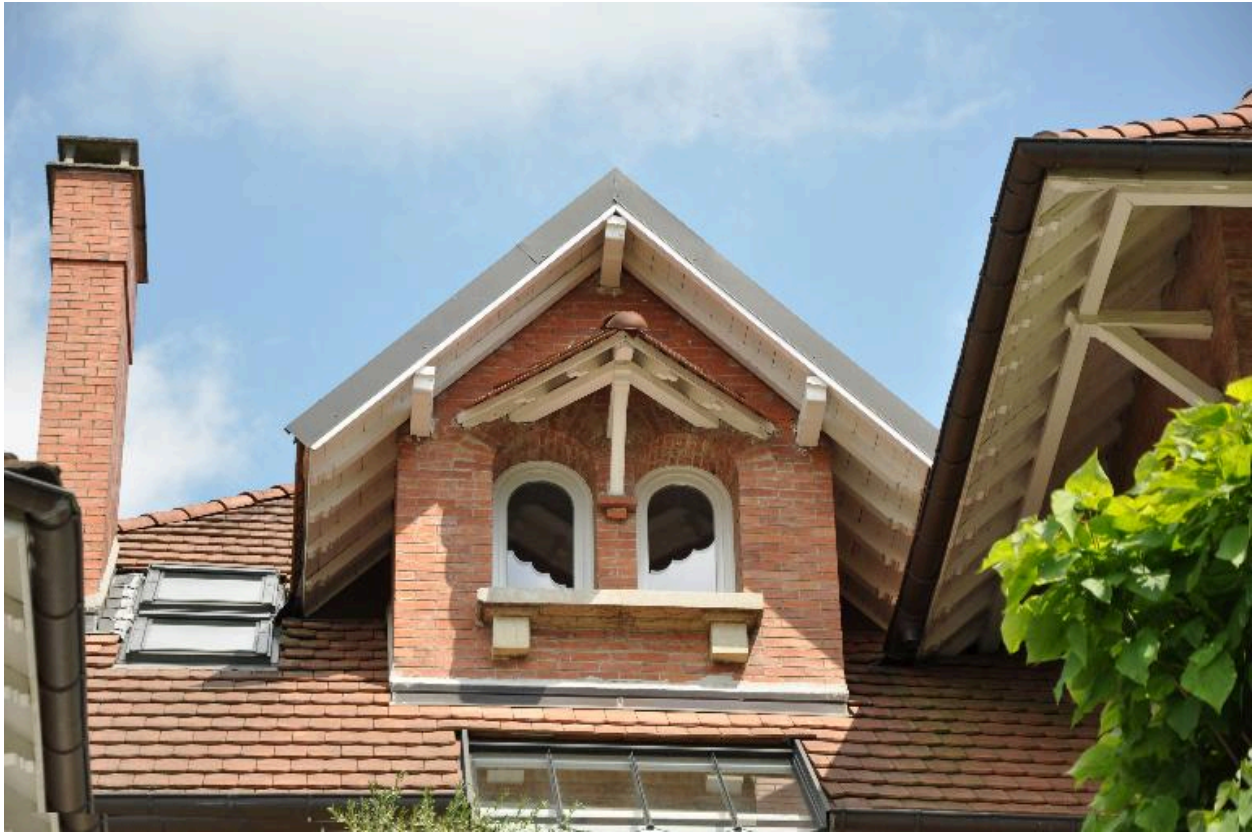
Lucarne à baies jumelées de la façade ouest
