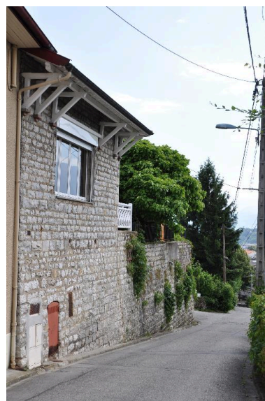
Elévation sur le chemin Alexandre Toudouze du corps de bâtiment nord-ouest Phot. Denys Harreau IVR82_20137300653NUCA
