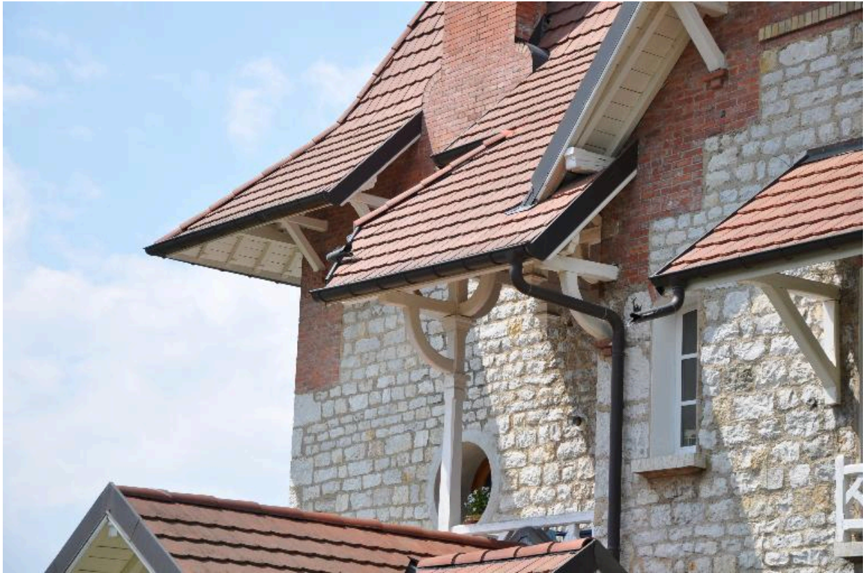
Détail de la façade sud, décrochements de toits et aisseliers en bois
