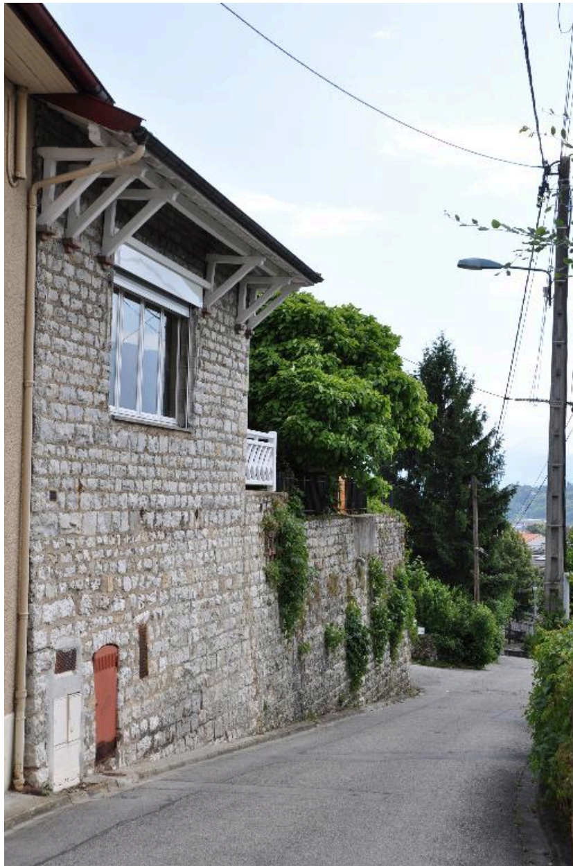
Elévation sur le chemin Alexandre Toudouze du corps de bâtiment nord-ouest
