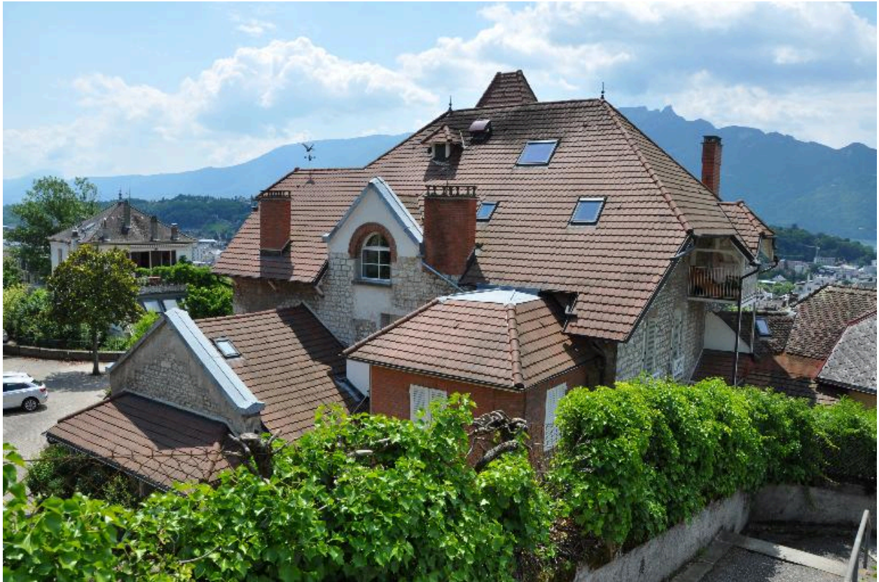
Vue générale depuis le nord-est, les toitures
