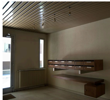
Hall d'entrée Phot. Maryannick Chalabi IVR82_20116901576NUCA
