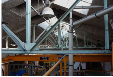
Charpente métallique Phot. Catherine Guégan IVR82_20116901925NUCA
