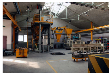
Sablerie SOPAME Phot. Catherine Guégan IVR82_20116901920NUCA
