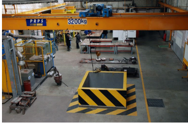
Fosse communicant avec le rez-de-chaussée du bâtiment Phot. Catherine Guégan IVR82_20116901924NUCA
