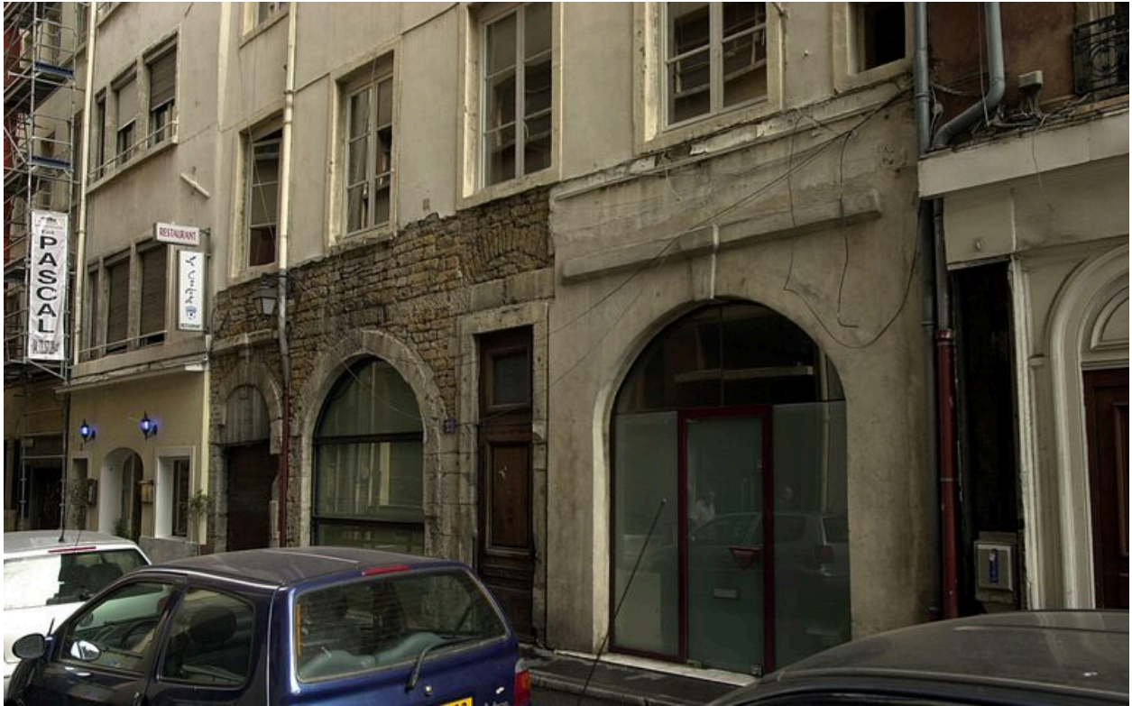
Vue de situation de la porte de l'allée conduisant à l'hôtel de la Monnaie
