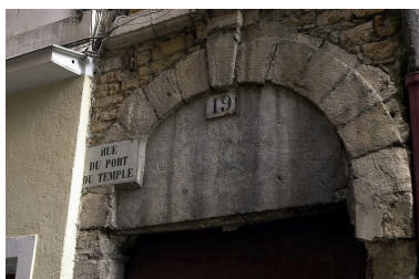
Détail du tympan du n°19 portant l'inscription L'HOSTEL DE LA MONNOYE, pierre sèche Phot. Véronique Belle IVR82_20086901292NUCA
