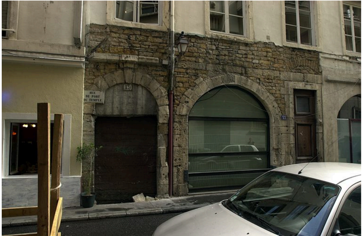
A gauche, la porte de l'allée conduisant jusqu'en 1830 à l'hôtel de la Monnaie
