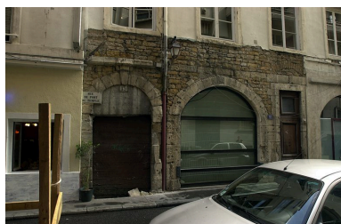
A gauche, la porte de l'allée conduisant jusqu'en 1830 à l'hôtel de la Monnaie Phot. Véronique Belle IVR82_20086901291NUCA
