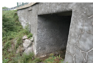
Pont de la Corbassière, détail de l'élargissement béton Phot. Pascale Renard IVR84_20207401244NUCA
