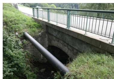
Pont de la Corbassière, vue de la face amont Phot. Pascale Renard IVR84_20207401241NUCA
