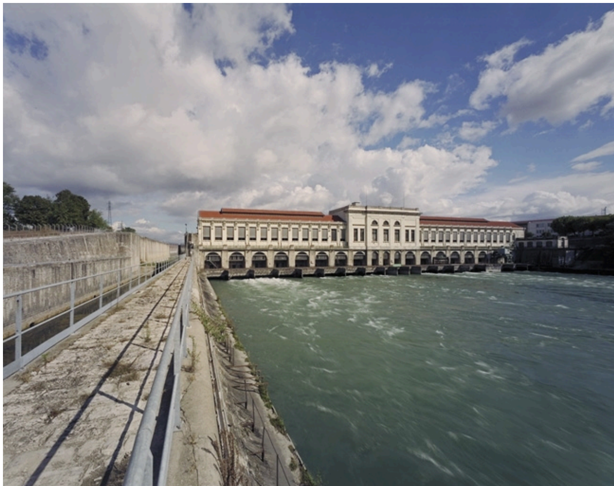
Vue générale, façade aval (est)
