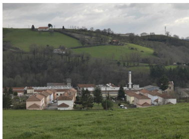
Vue d'ensemble de la cité Jalla Phot. Thierry Leroy IVR84_20164200166NUCAQ
