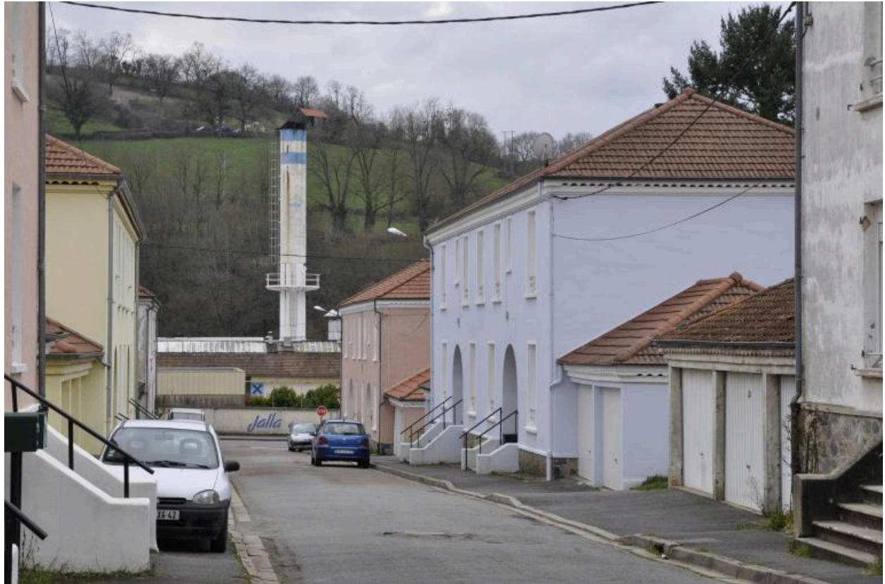
Vue de la cité et de la cheminée d'usine
