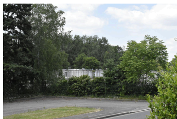
Montluçon (Allier). Vue du lycée Maurice-Guyot depuis la rue. Ce lycée est représentatif du lycée situé en lisière de ville, discret, et dont l'implantation des bâtiments est centripète sur le fonds.
