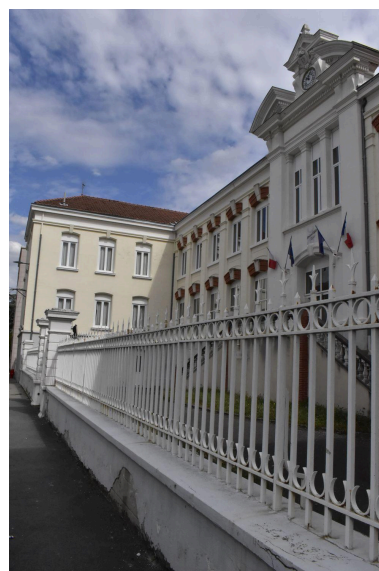
Firminy (Loire). Lycée Jacob-Holtzer. Une cour d'entrée du quatrième quart du 19e siècle. Phot. Bénédicte Renaud-Morand IVR84_20234200199NUCA
