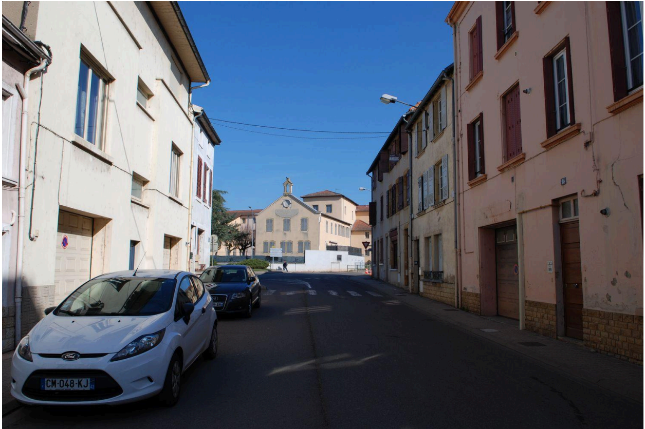
Charlieu (Loire). Axiation, depuis une rue du centre-ville, sur le pignon de l'école supérieure et professionnelle, actuellement lycée, située au-delà d'un carrefour, en lisière de ville à l'origine.
