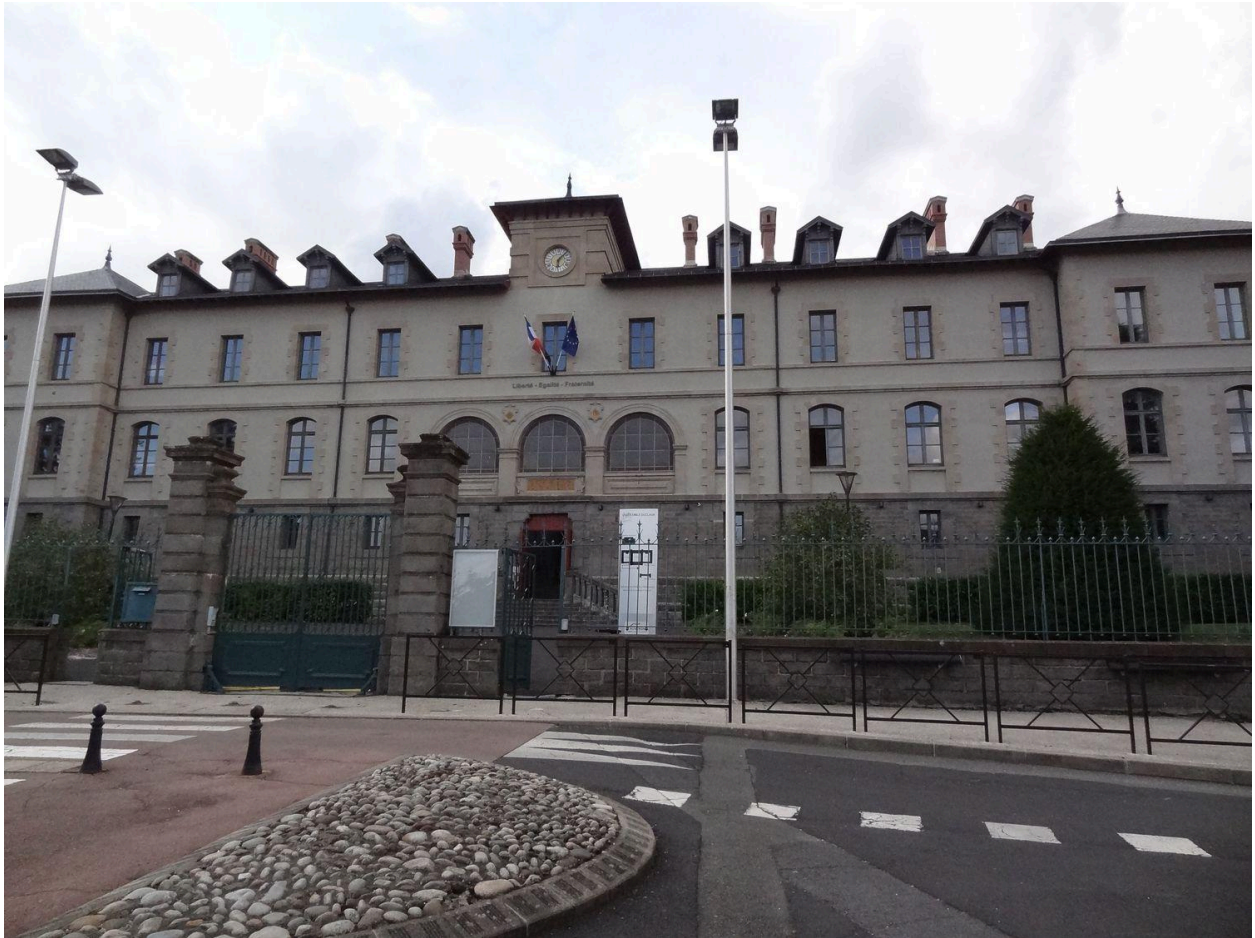
Aurillac (Cantal). 16 avenue Henri-Mondor. Lycée de garçons, actuel lycée Emile-Duclaux, par J.J. Gustave Lisch (1887-1891). Lycée monumental, en position dominante, lié à la création d'une rue et dont la tendance d'implantation sur la parcelle est centrifuge.
