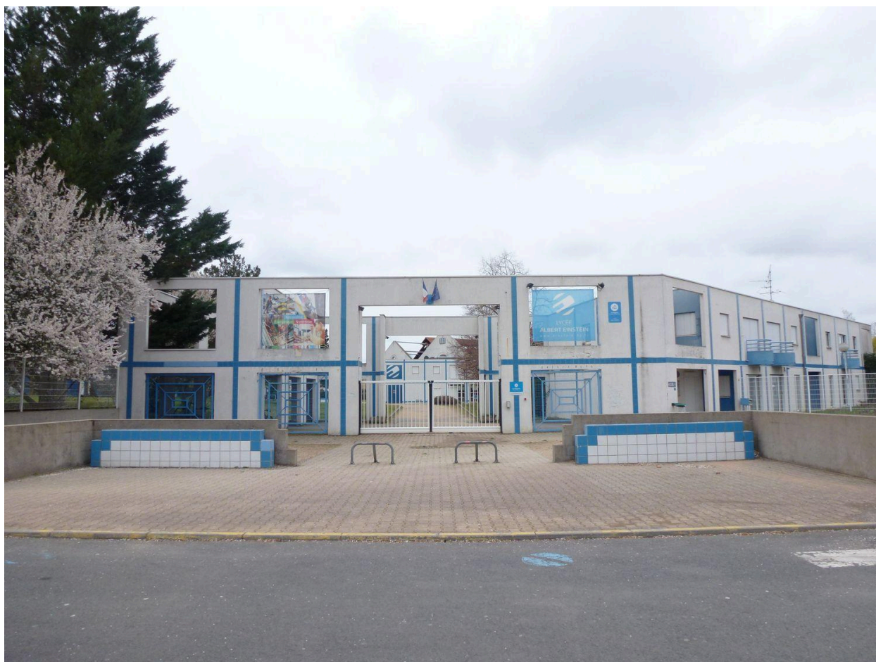
Montluçon (Allier). Lycée Albert-Einstein. Une cour d'entrée du 4e quart du 20e siècle.
