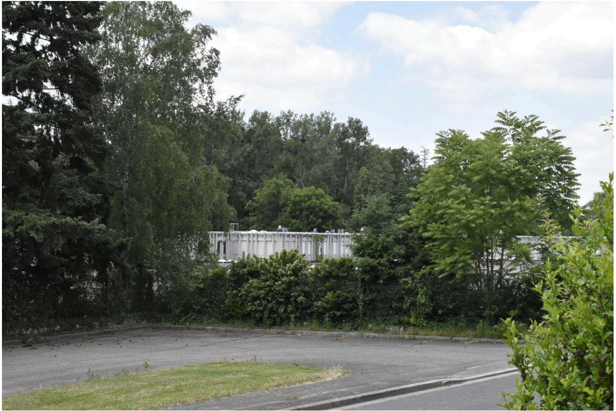
Montluçon (Allier). Vue du lycée Maurice-Guyot depuis la rue. Ce lycée est représentatif du lycée situé en lisière de ville, discret, et dont l'implantation des bâtiments est centripète sur le fonds.
