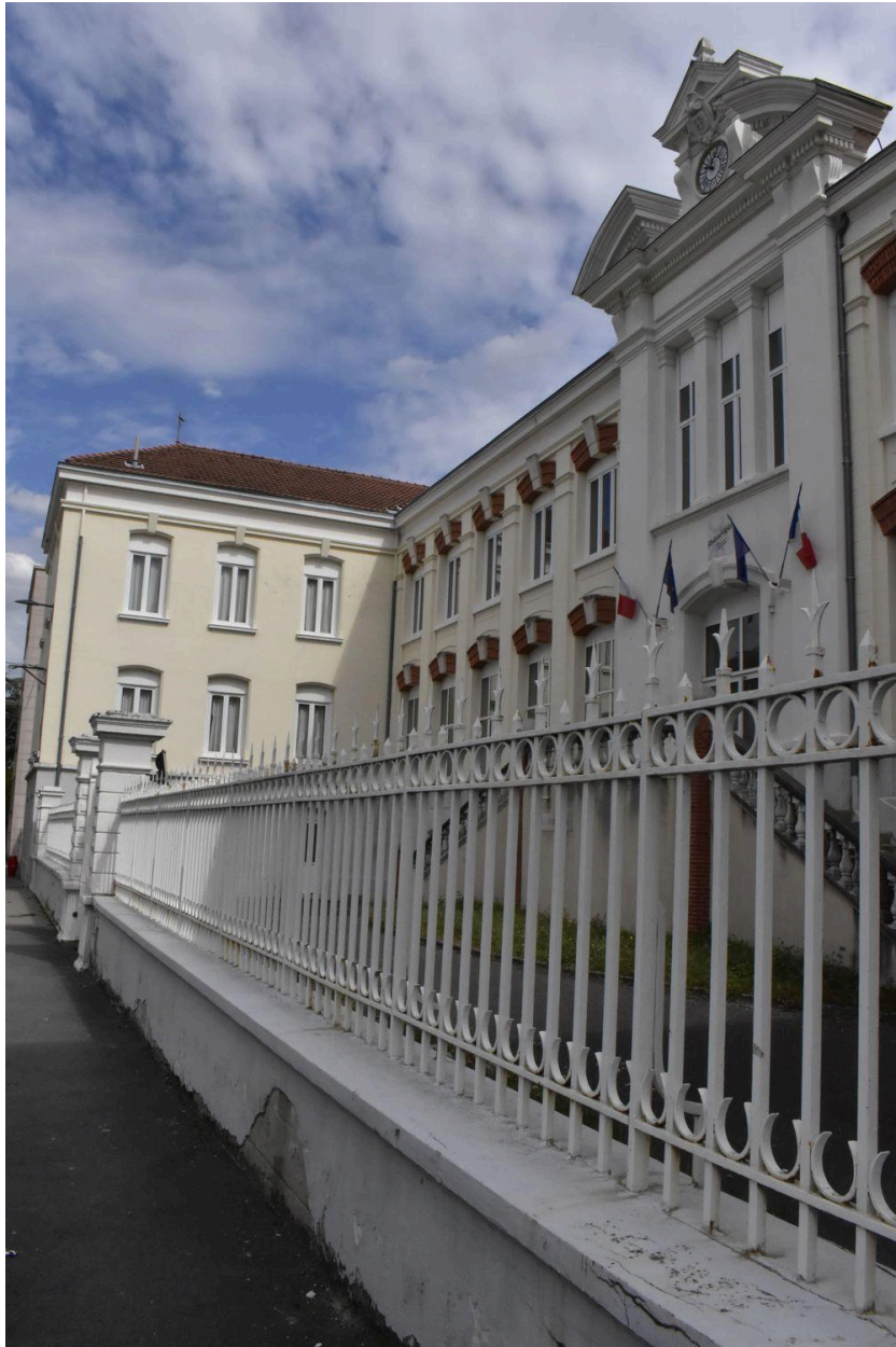
Firminy (Loire). Lycée Jacob-Holtzer. Une cour d'entrée du quatrième quart du 19e siècle.
