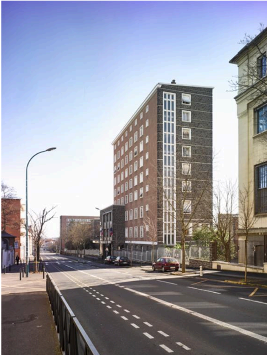
Un lycée en espace urbain (le lycée Blaise-Pascal de Clermont-Ferrand, situé avenue Carnot). Prototype du lycée construit à partir de la trame élémentaire de 1,75 m (Circulaire, 1er septembre 1952).
