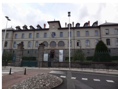
Aurillac (Cantal). 16 avenue Henri-Mondor. Lycée de garçons, actuel lycée Emile-Duclaux, par J.J. Gustave Lisch (1887-1891). Lycée monumental, en position dominante, lié à la création d'une rue et dont la tendance d'implantation sur la parcelle est centrifuge. Phot. Bénédicte Renaud-Morand IVR84_20231500021NUCA
