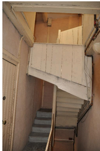
Vue du dernier niveau de l'escalier Phot. Nadine Halitim-Dubois IVR82_20146900377NUCA
