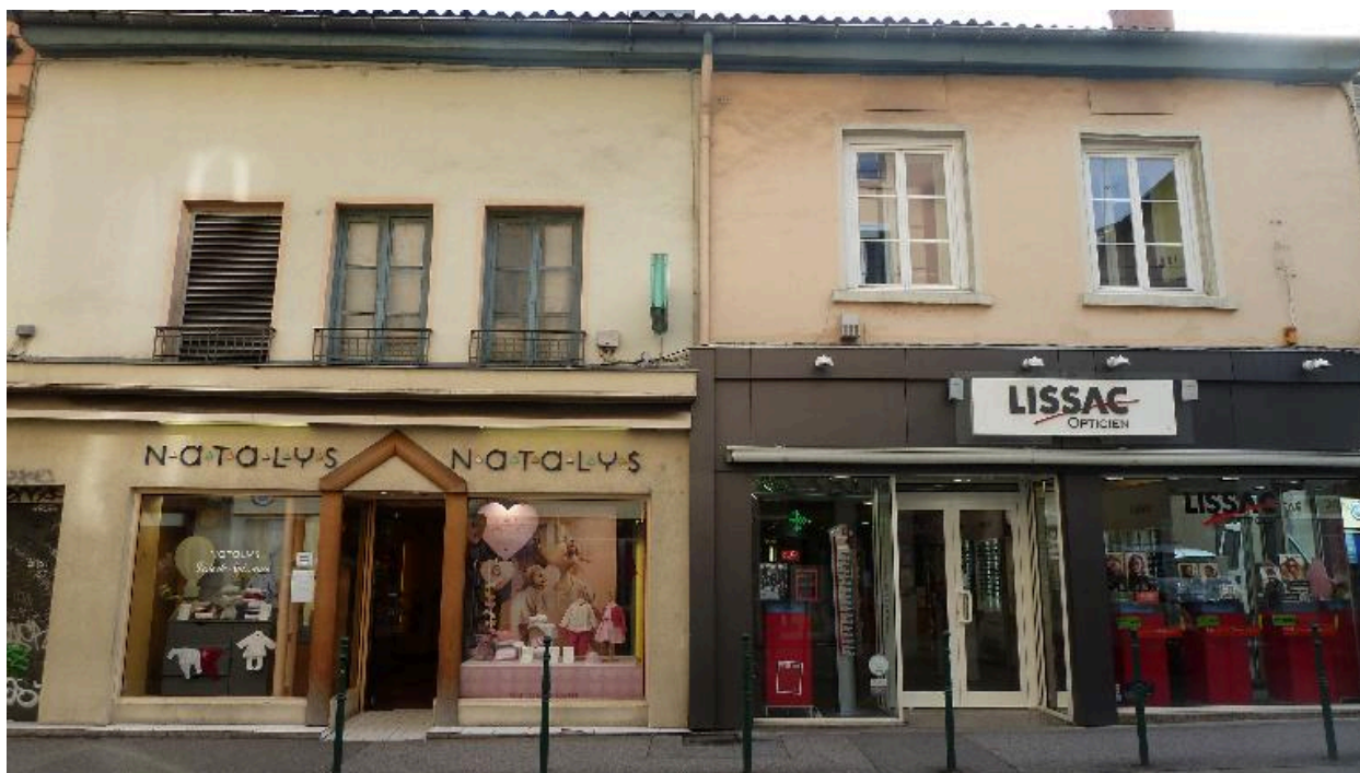
Vue d'ensemble ouest des n° 20 et 22
