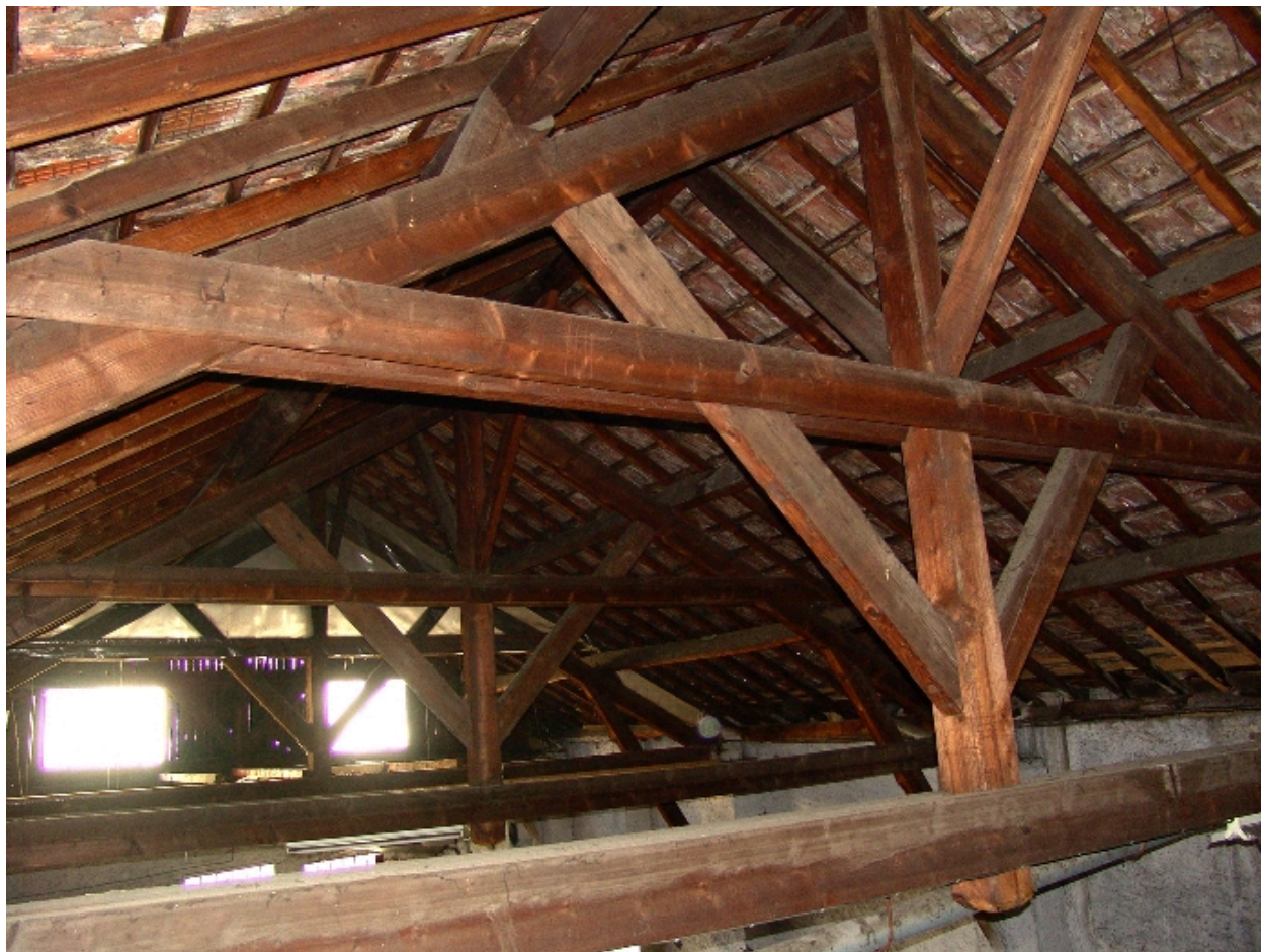
Garage de réparations automobiles : charpente de l'atelier
