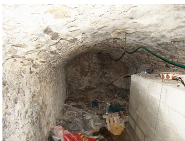
Vue d'une cave Phot. François Fouger IVR82_20057300003NUCA
