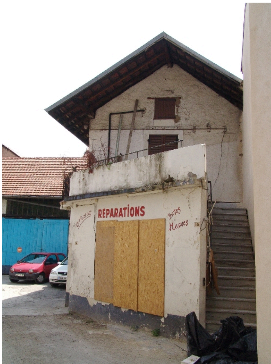
Garage de réparations automobiles : aile droite
