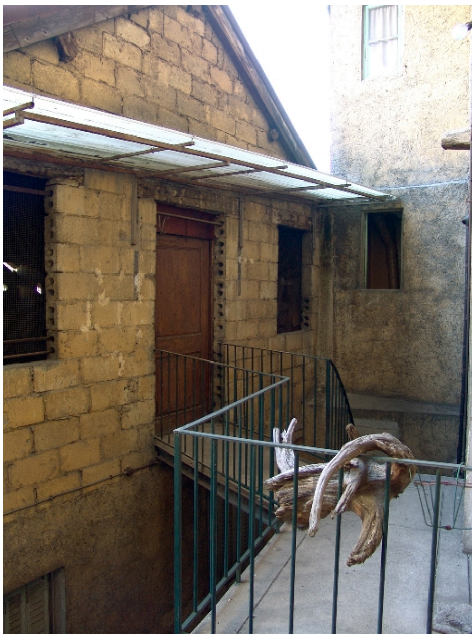
Passerelle entre le 1er étage et les dépendances
