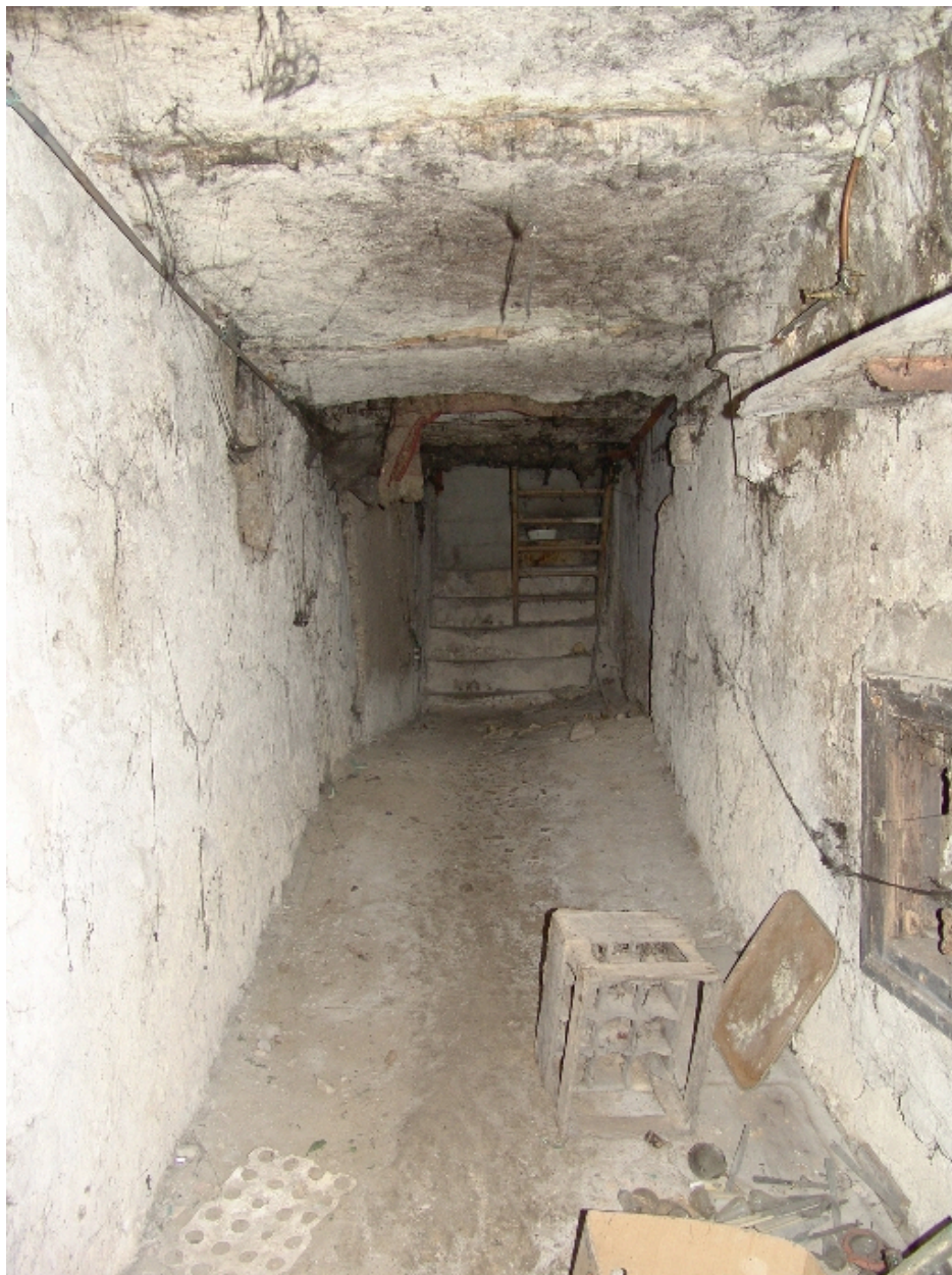
Couloir d'accès aux caves
