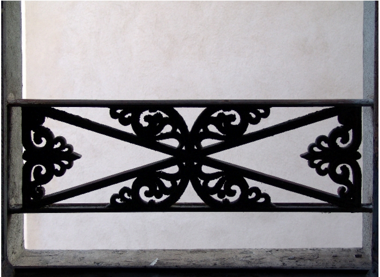
Garde-corps du 2e étage, côté rue
