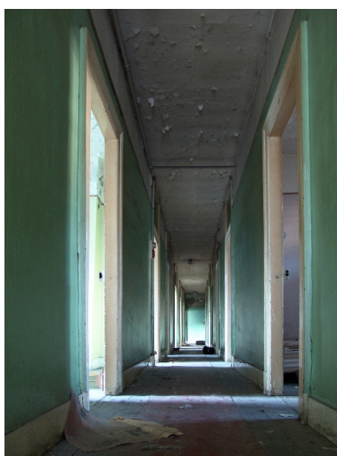
Couloir du 2e étage Phot. François Fouger IVR82_20057300012NUCA
