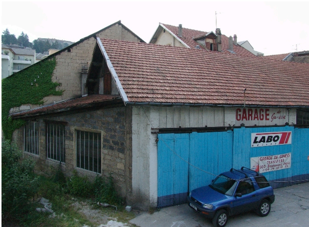
Garage de réparations automobiles : vue de trois-quart
