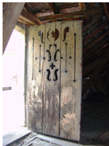
Dépendances : vantail d'une lucarne Phot. François Fouger IVR82_20057300025NUCA
