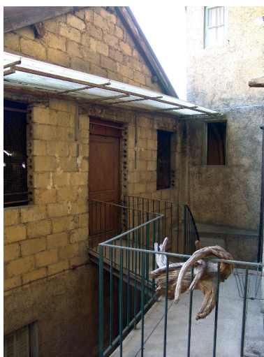
Passerelle entre le 1er étage et les dépendances Phot. François Fouger IVR82_20057300009NUCA
