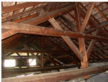
Garage de réparations automobiles : charpente de l'atelier Phot. François Fouger IVR82_20057300030NUCA
