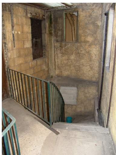
Escalier extérieur Phot. François Fouger IVR82_20057300008NUCA
