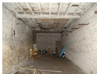
Dépendances : intérieur Phot. François Fouger IVR82_20057300026NUCA
