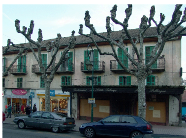
Façade sur rue Phot. François Fouger IVR82_20057300018NUCA
