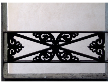
Garde-corps du 2e étage, côté rue Phot. François Fouger IVR82_20057300013NUCA
