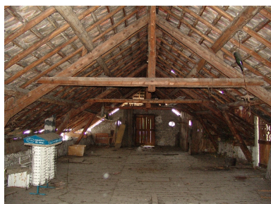
Dépendances : charpente Phot. François Fouger IVR82_20057300024NUCA
