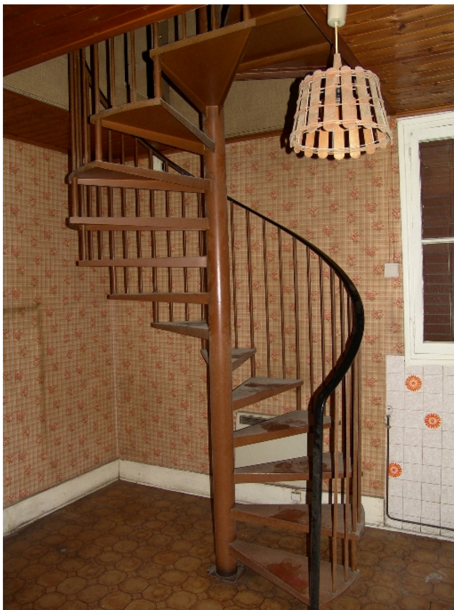
Garage de réparations automobiles : escalier du logement
