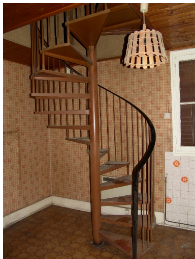
Garage de réparations automobiles : escalier du logement Phot. François Fouger IVR82_20057300029NUCA
