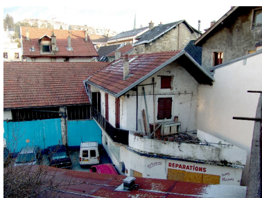
Garage de réparations automobiles : vue d'ensemble Phot. François Fouger IVR82_20057300031NUCA
