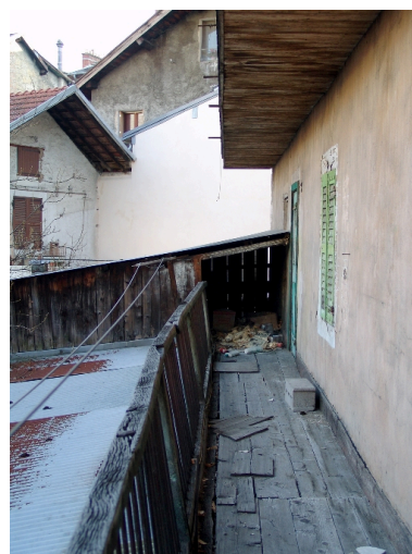
balcon postérieur Phot. François Fouger IVR82_20057300007NUCA
