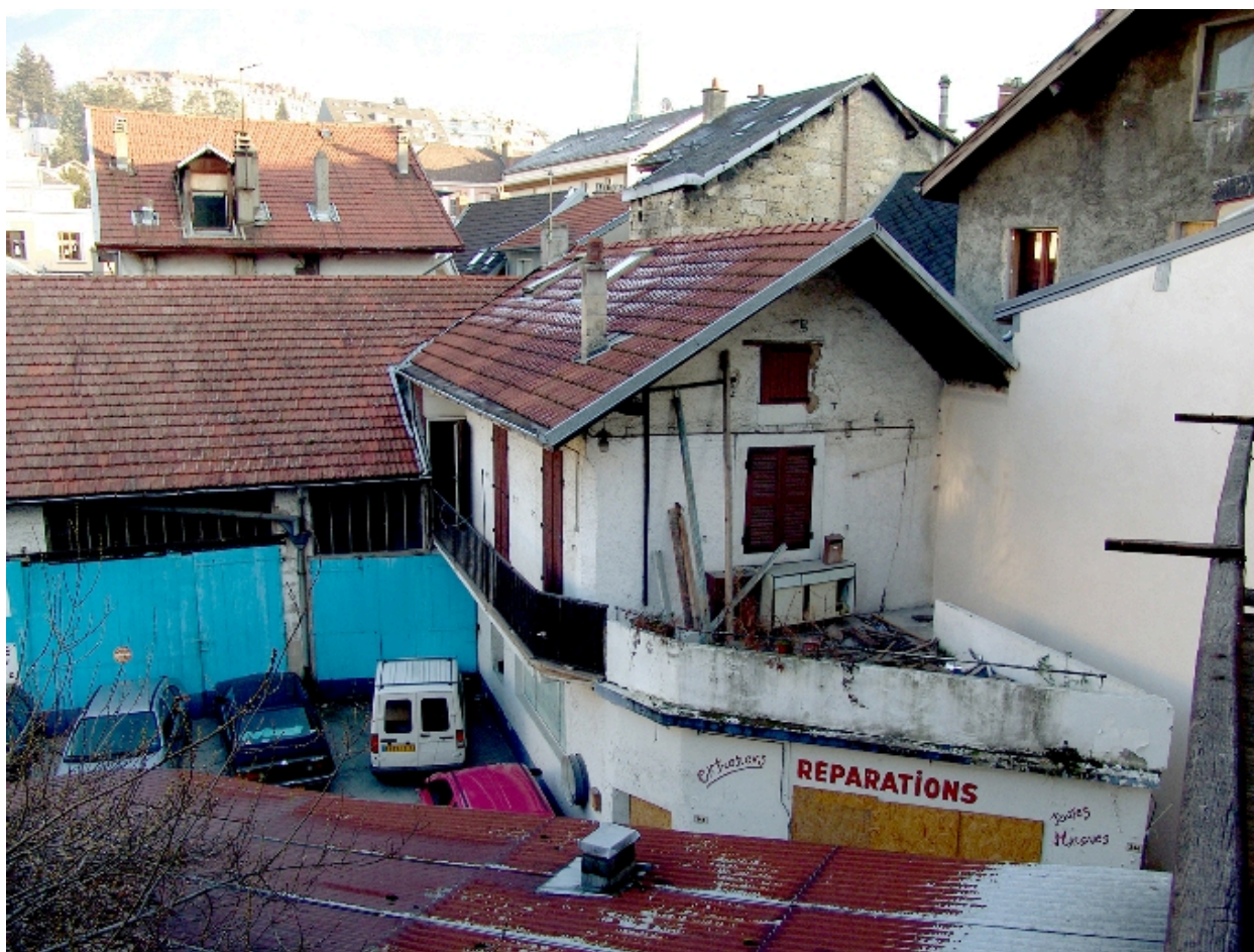
Garage de réparations automobiles : vue d'ensemble
