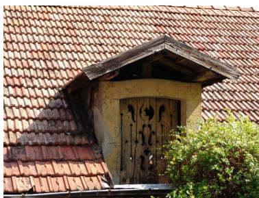
Dépendances : lucarne Phot. François Fouger IVR82_20057300023NUCA
