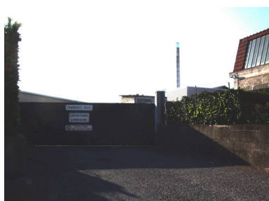
Vue d'ensemble de la tannerie Phot. Nadine Halitim-Dubois IVR82_20102600677NUCA
