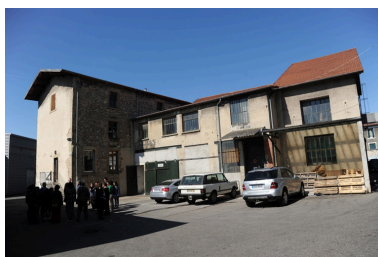
Vue d'ensemble de la tannerie Phot. Nadine Halitim-Dubois IVR82_20102600685NUCA
