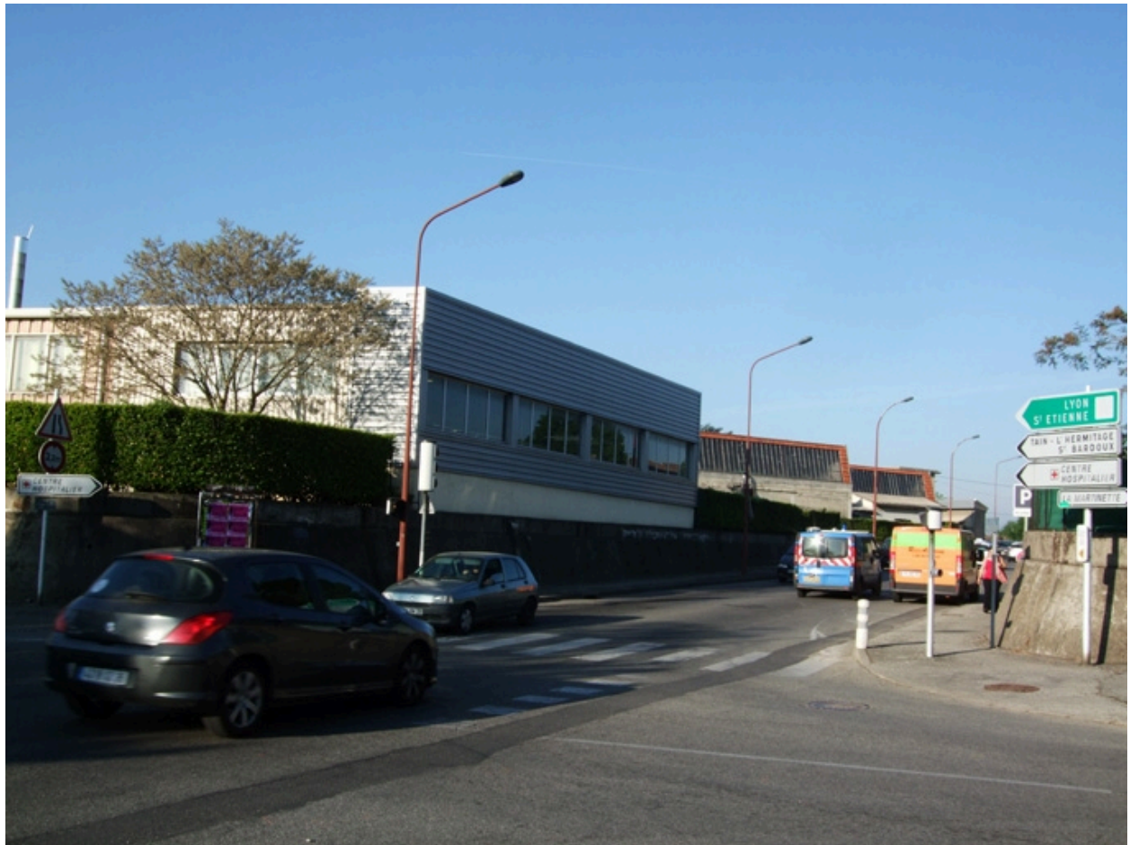
Vue générale nord, toiture shed
