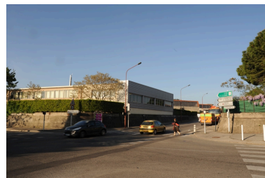
Vue d'ensemble de la tannerie Phot. Nadine Halitim-Dubois IVR82_20102600673NUCA
