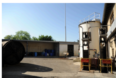
Vue d'ensemble de la tannerie Phot. Nadine Halitim-Dubois IVR82_20102600687NUCA
