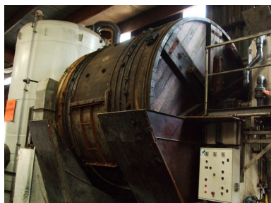
Vue d'ensemble de la tannerie : machines Phot. Nadine Halitim-Dubois IVR82_20102600681NUCA
