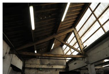
Vue d'ensemble de la tannerie Phot. Nadine Halitim-Dubois IVR82_20102600676NUCA
