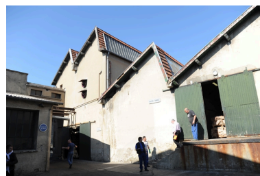
Vue d'ensemble de la tannerie Phot. Nadine Halitim-Dubois IVR82_20102600686NUCA
