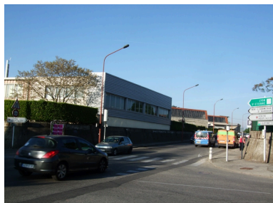
Vue générale nord, toiture shed Phot. Nadine Halitim-Dubois IVR82_20102600671NUCA
