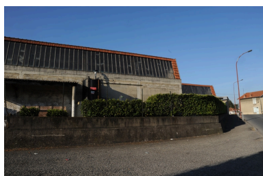
Détail toiture Phot. Nadine Halitim-Dubois IVR82_20102600674NUCA
