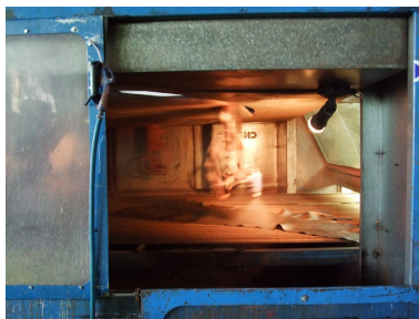
Vue intérieure : machine Phot. Nadine Halitim-Dubois IVR82_20102600720NUCA
